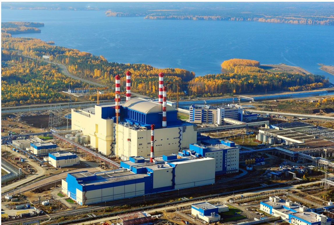
Рисунок 1.2.1 - Энергоблок № 4 Белоярской АЭС
