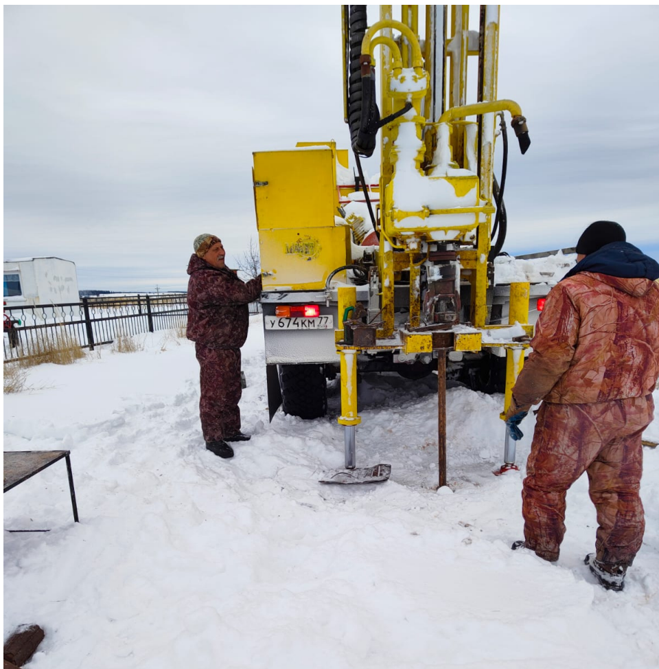
Рис. 1-Бурение скважины С-2032 установкой УРБ-2А-2
