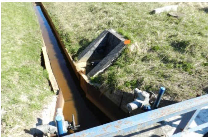
Рисунок 11. Магистральный канал. Оголовок выпуска очищенных стоков.
