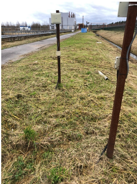
Рисунок 30. Стойки для периметровой охранной сигнализации.
