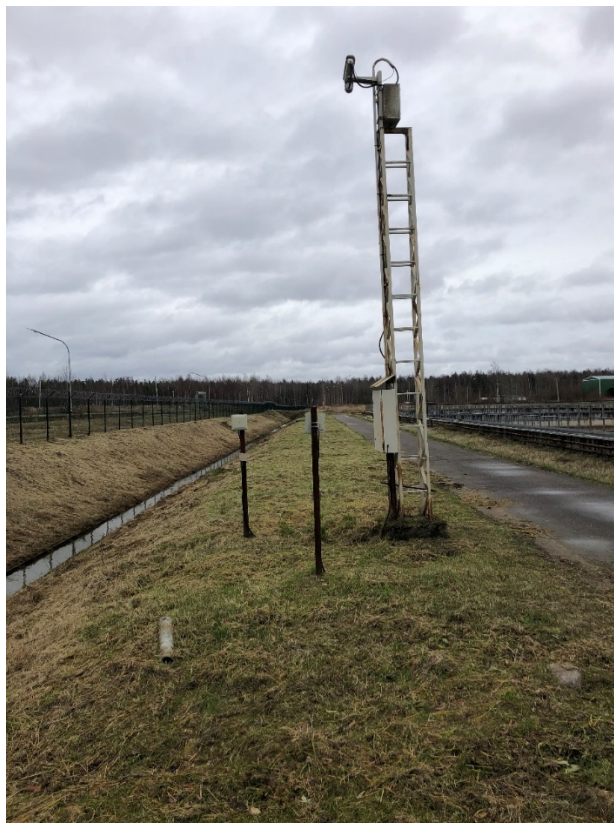
Рисунок 29. Мачтовая опора, предназначенная для установки видеокамер и стойки охранной сигнализации.
