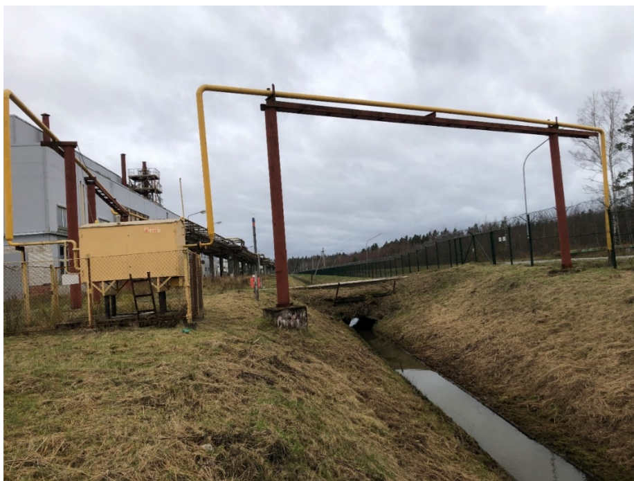
Рисунок 28. Существующий надземный газопровод, проходящий по высокой эстакаде в зоне трассы ПФЗ
