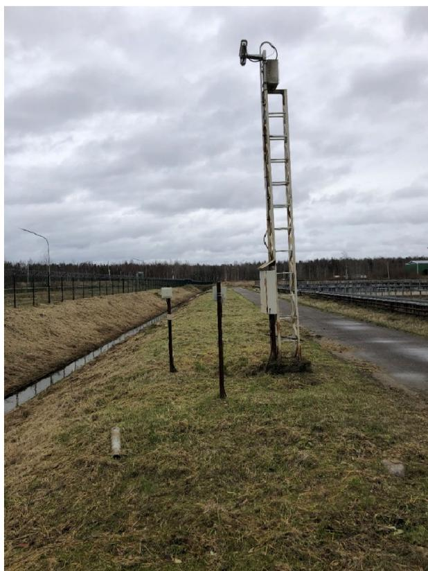
Рисунок 15. Мачтовая опора, предназначенная для установки видеокамер и стойки охранной сигнализации.
