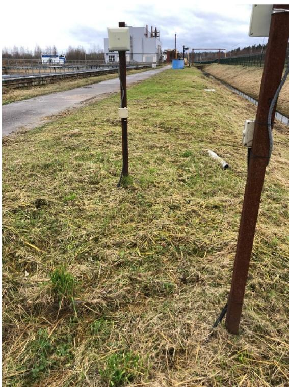
Рисунок 16. Стойки для периметровой охранной сигнализации.
