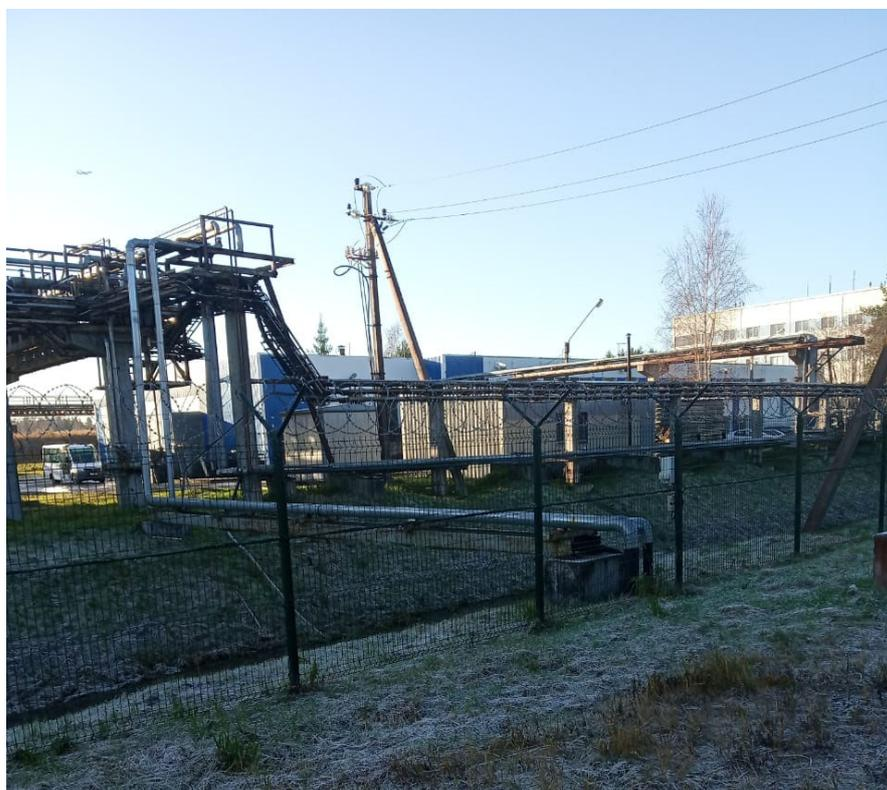
Рисунок 13. Существующая надземная прокладка труб водоотведения в зоне трассы ПФЗ.
