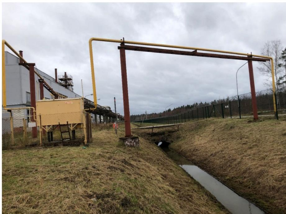
Рисунок 14. Существующий надземный газопровод, проходящий по высокой эстакаде в зоне трассы ПФЗ
