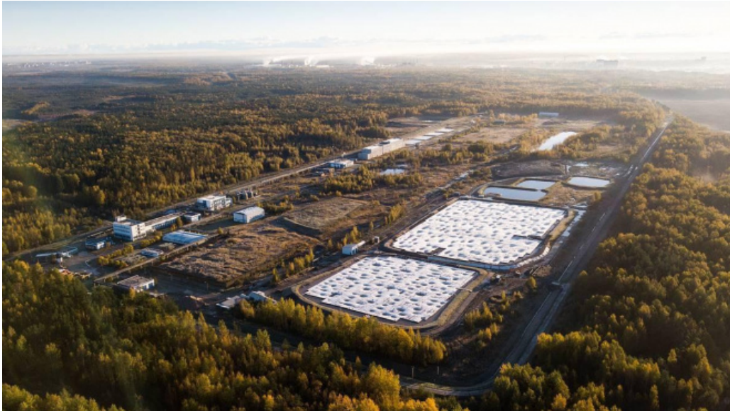
Рисунок 5. Карты полигона. На переднем плане карты №№68, 64 с временным геомембранным покрытием на понтонах.
