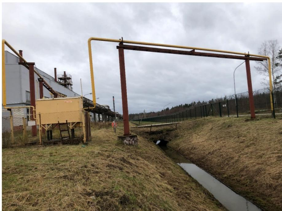
Рисунок 17. Существующий надземный газопровод, проходящий по высокой эстакаде в зоне трассы ПФЗ
