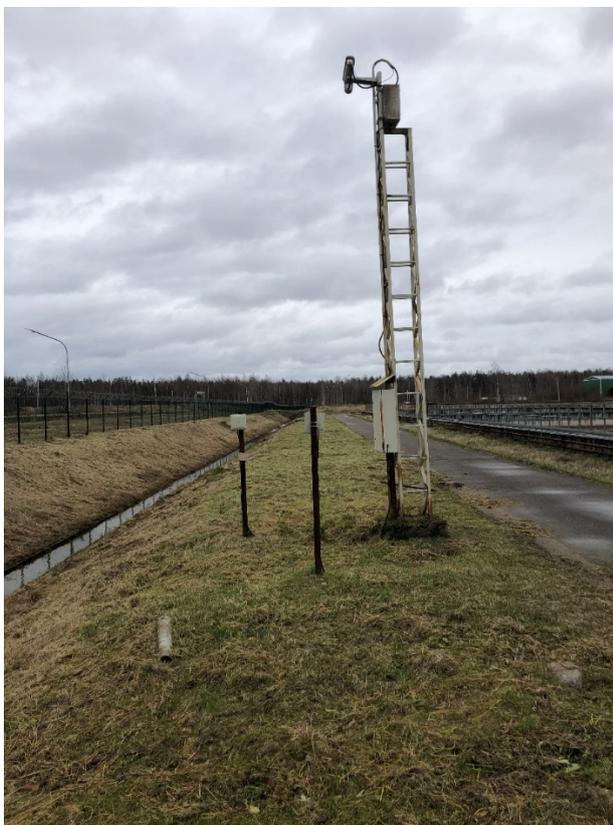
Рисунок 18. Мачтовая опора, предназначенная для установки видеокамер и стойки охранной сигнализации.
