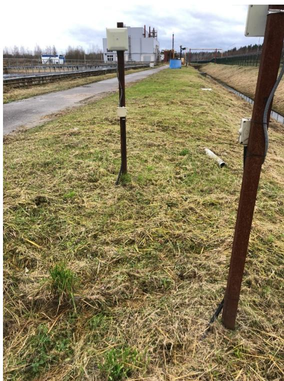
Рисунок 19. Стойки для периметровой охранной сигнализации.
