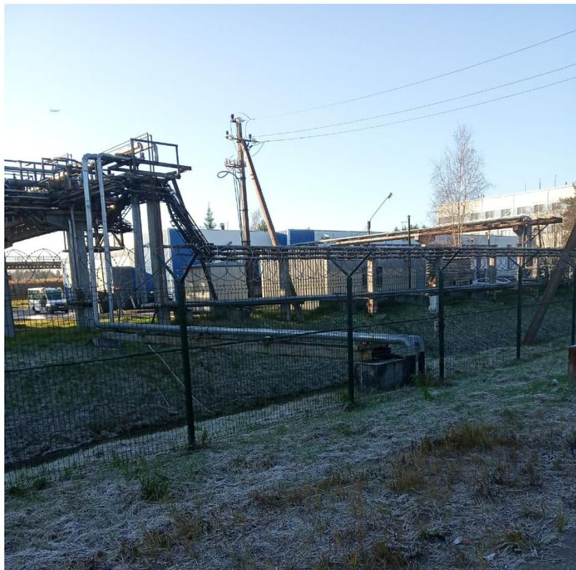
Рисунок 16. Существующая надземная прокладка труб водоотведения в зоне трассы ПФЗ.
