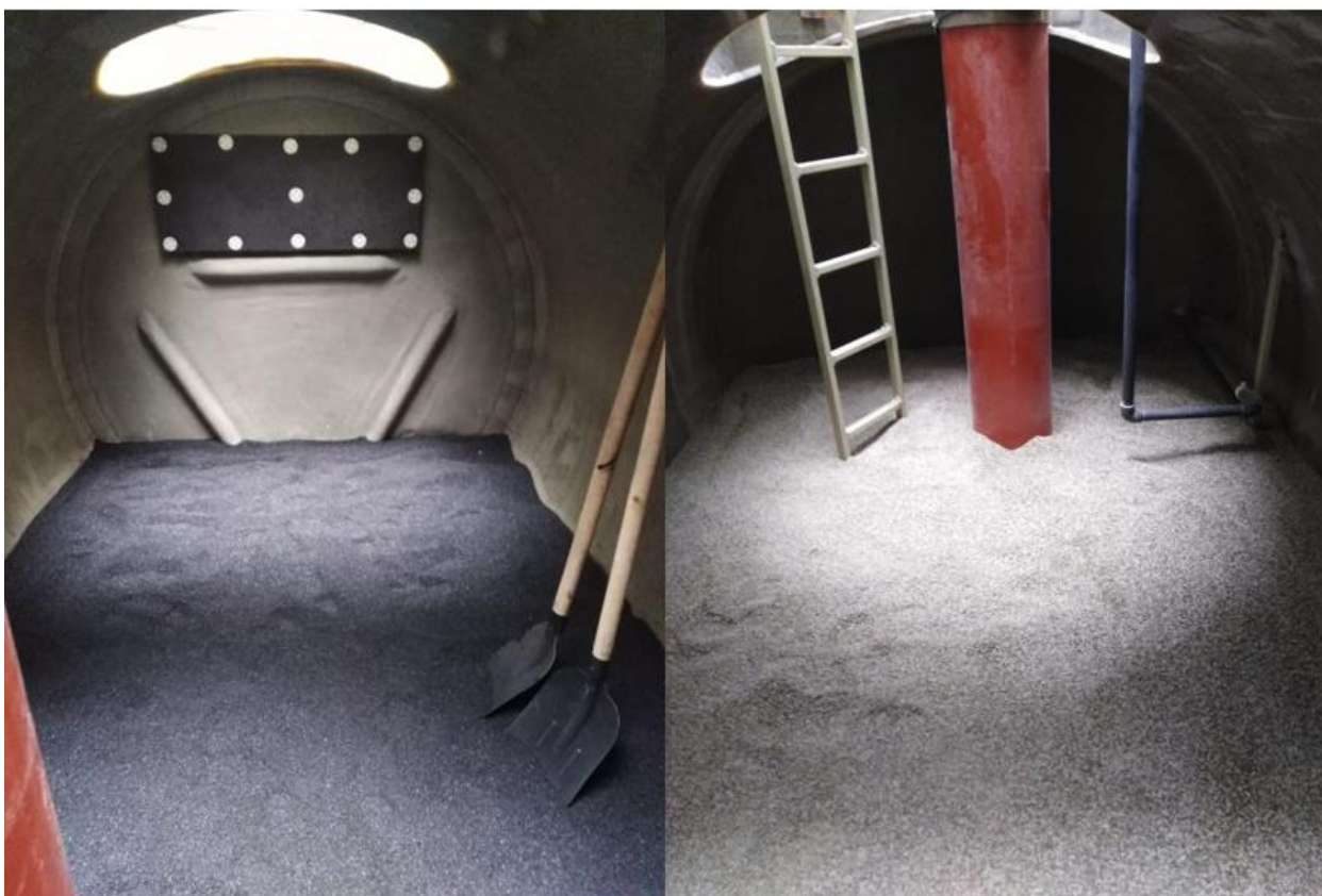
Загрузка сорбционного фильтра (сорбент II и I ступени) в установке Векса-С
