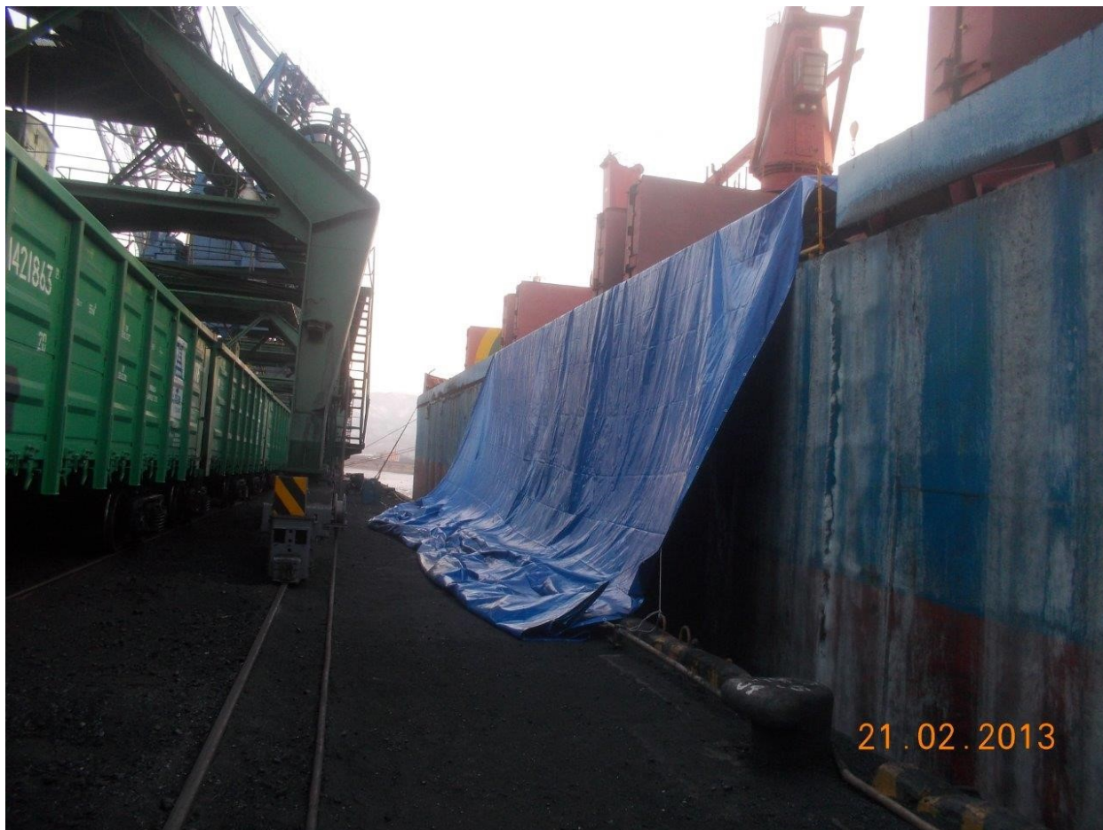
Рисунок 4.6-1. Полог, предотвращающий попадание угля в акваторию
