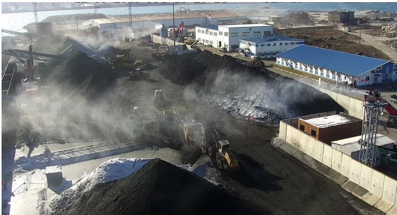
Рисунок 5.1-11. Работа сети из 4-х установок пылеподавления с централизованным управлением в зимний период
