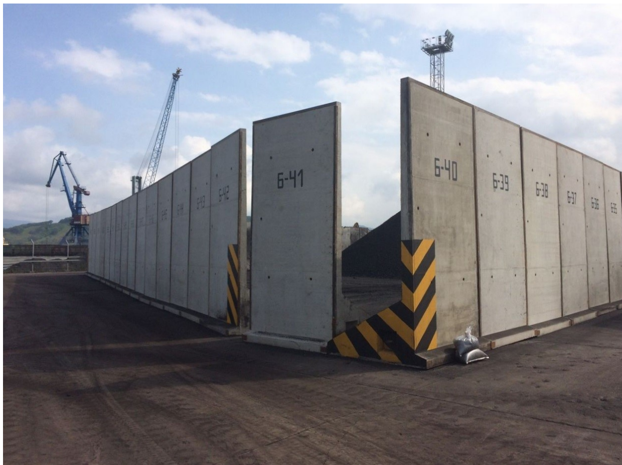
Рисунок 5.1-2. Подпорная стена СП1
