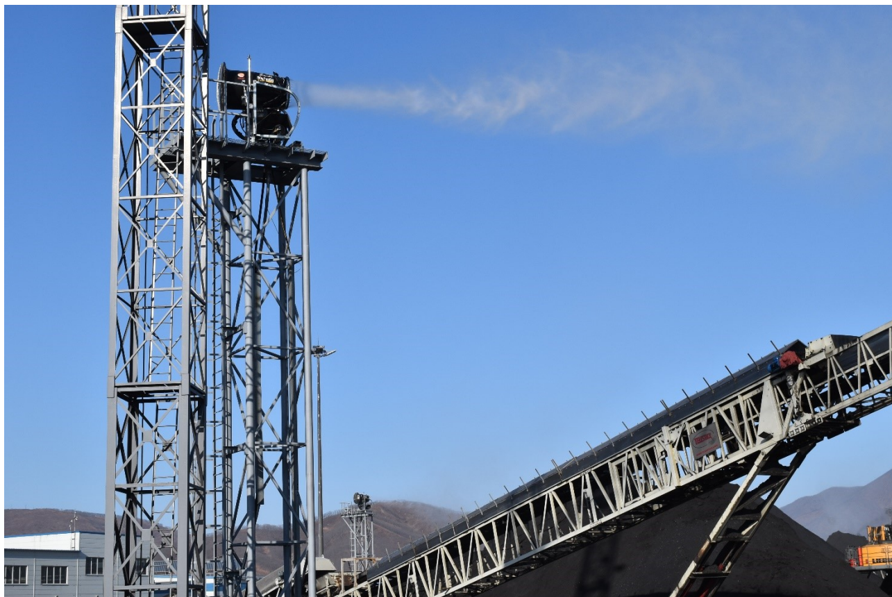
Рисунок 5.1-9. Работа одной установки пылеподавления в районе ленточного конвейера летний период
