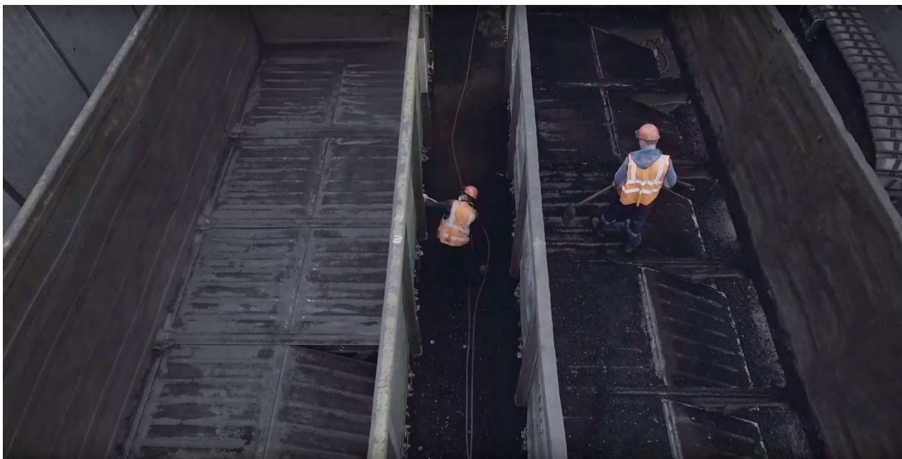
Рисунок 1.1-4. Зачистка вагонов после разгрузки угля
