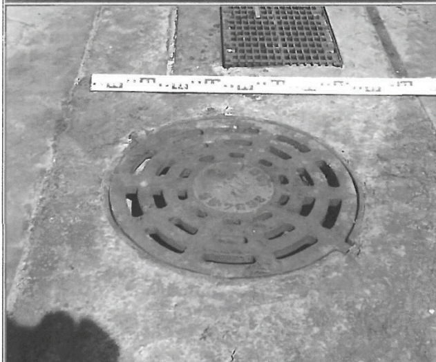
Фото 6 ПК 0+5 Водоотводный канал и колодец
