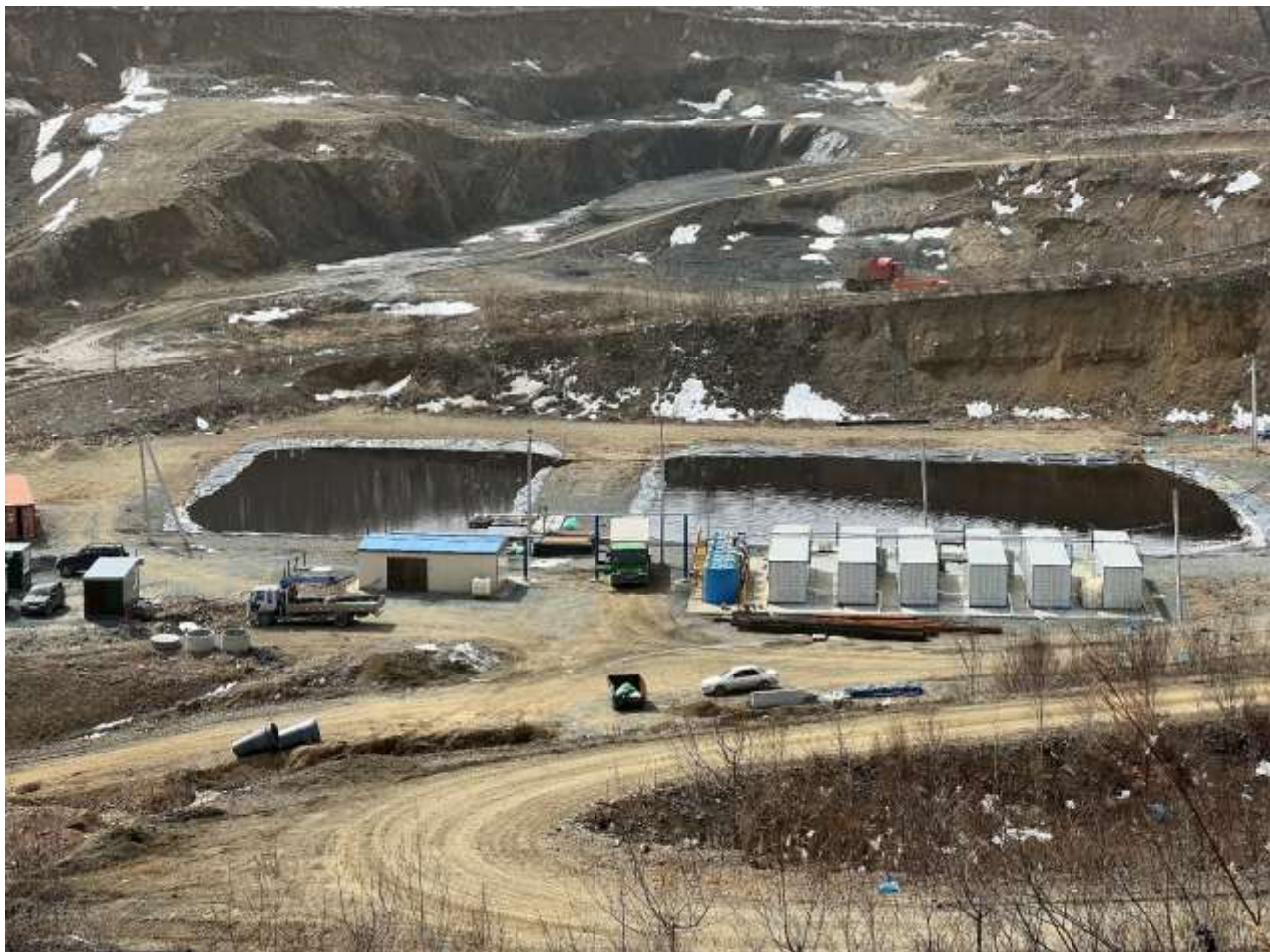
Рисунок 4.4.5 Пруды-отстойники на участке изысканий Тления и горения свалочных масс на участке изысканий зафиксировано не было. С западной границы участка объекта протекает с северо-запада на юго-восток ручей Безымянный (рис. 4.4.6).
