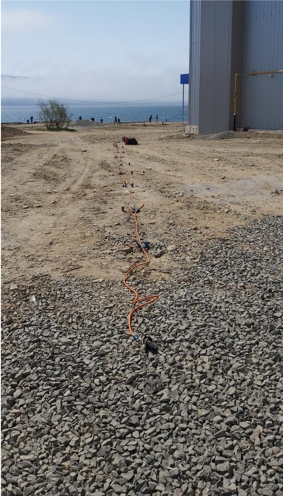
Рисунок 3.4 – Расстановка сейсмических датчиков на участке изысканий, сейсмический профиль СП-1
