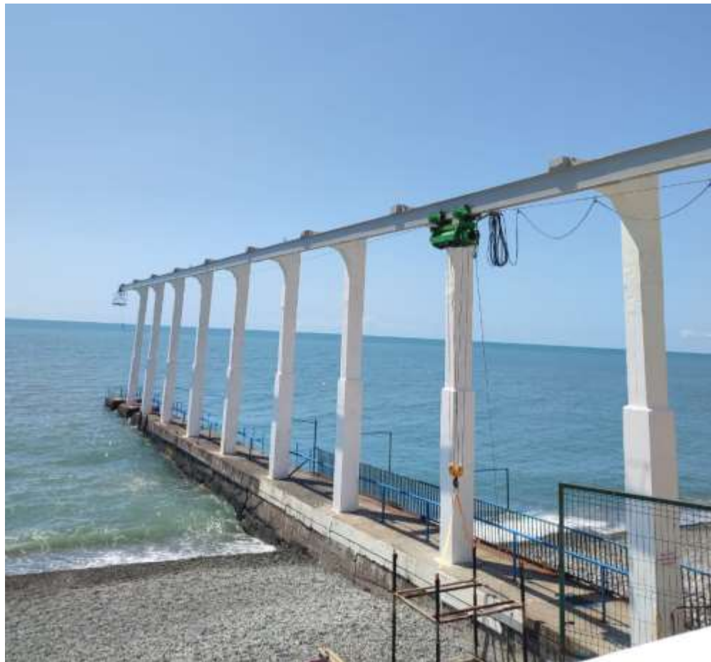
Рисунок 1 – Лодочная станция с тельфером
