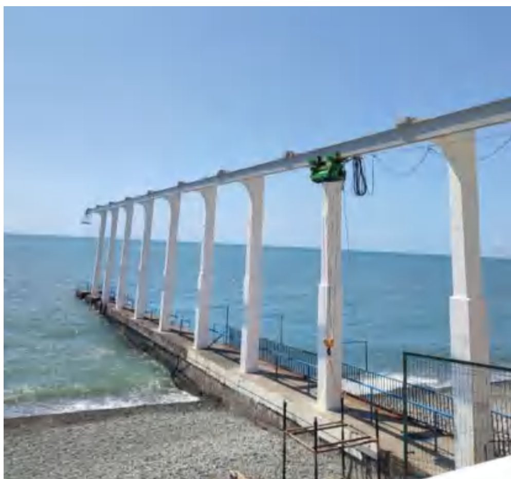
Рисунок 1 – Лодочная станция с тельфером
