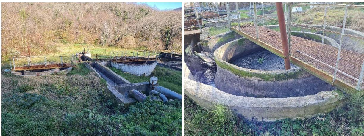
Рисунок 2.1 – Приемная камера и песковки
