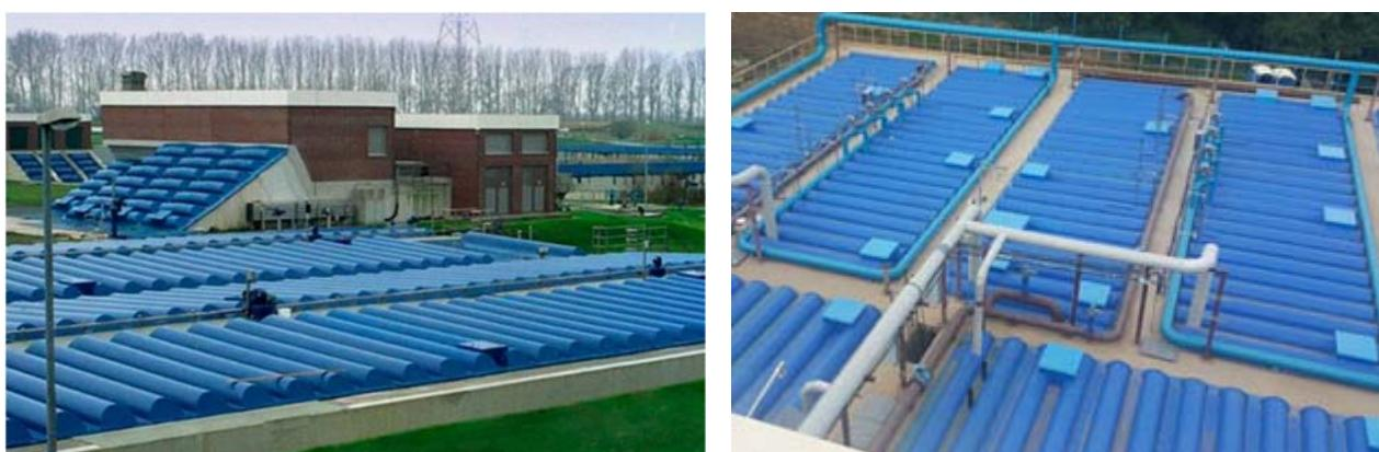
Рисунок 4.2.3 – Перекрытие сооружений (пример)
