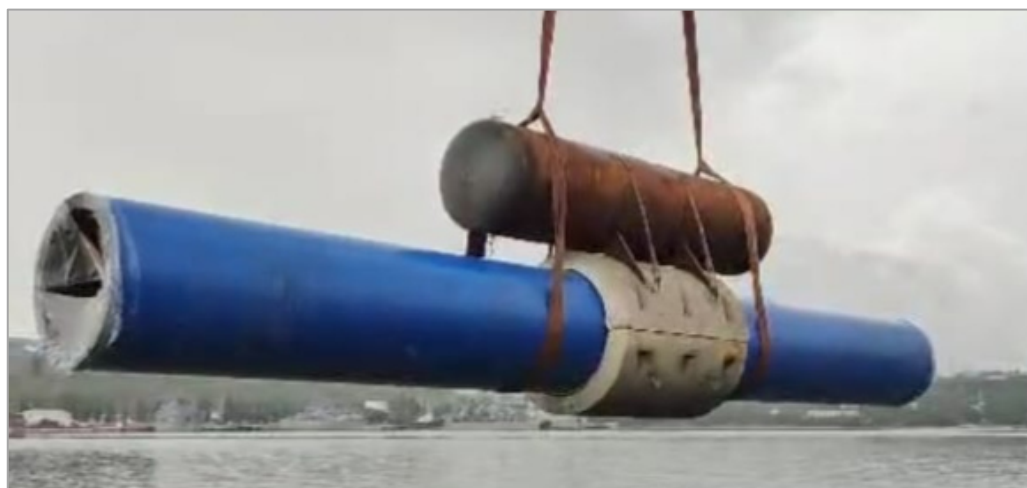
Рисунок 2.4.3 -Балластировка трубопровода пригрузами и системой вспомогательных устройств (СВУ)
