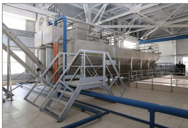
Рисунок 2.1.1 – Комбинированная установка механической очистки (пример)
