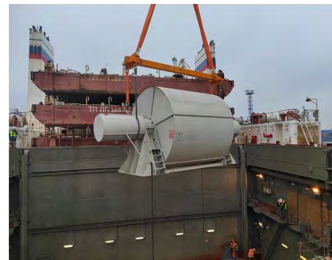
Рис. 11 Подъем тяжеловесного оборудования.
