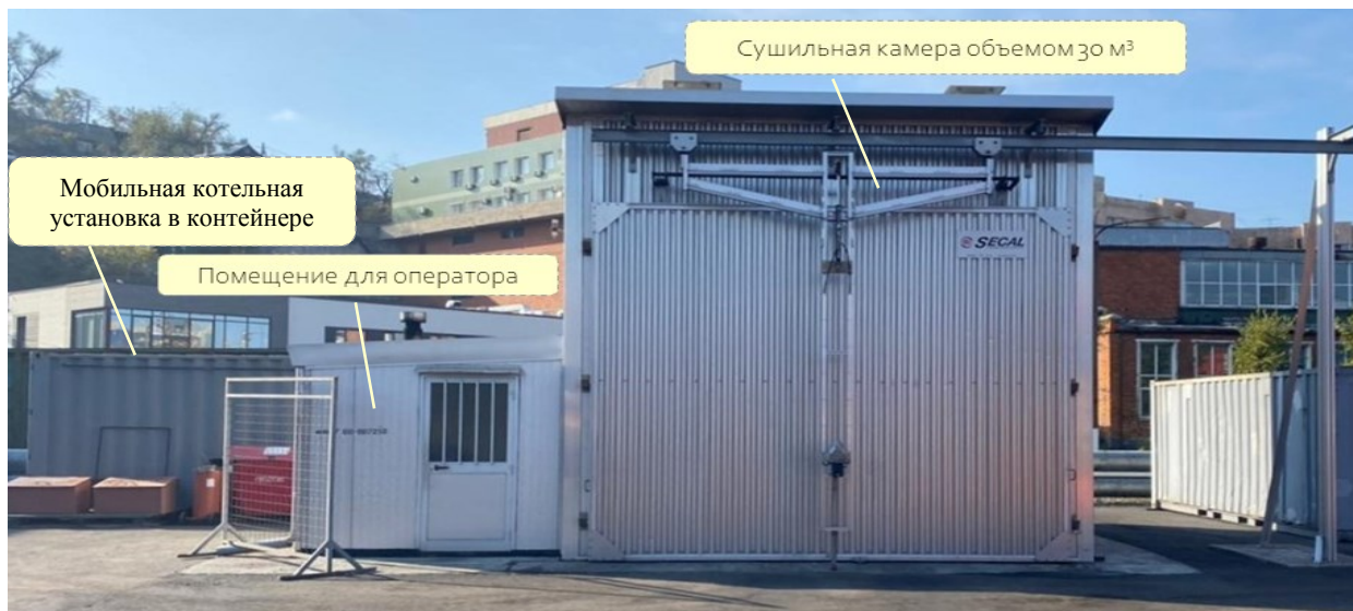
Рисунок 3.10 – Внешний вид сушильной камеры Secal тип EPL HT
