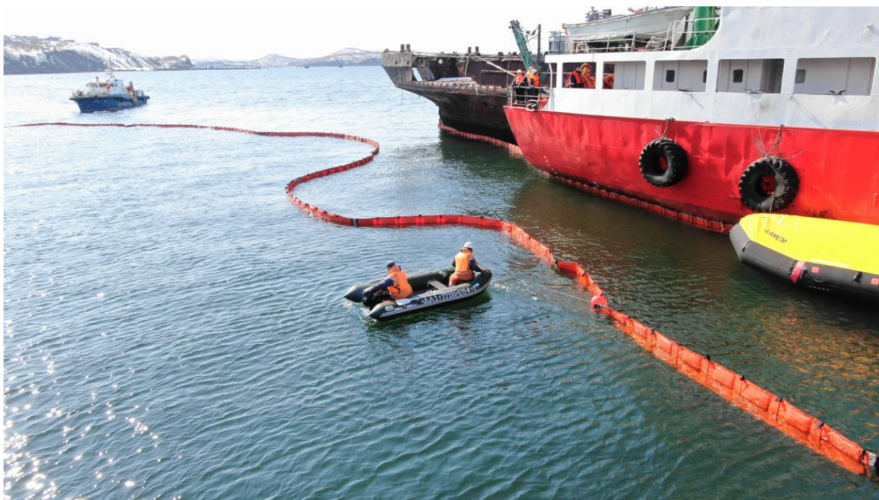
Рисунок 3.9. Постановка бонового ограждения при бункеровке в акватории
