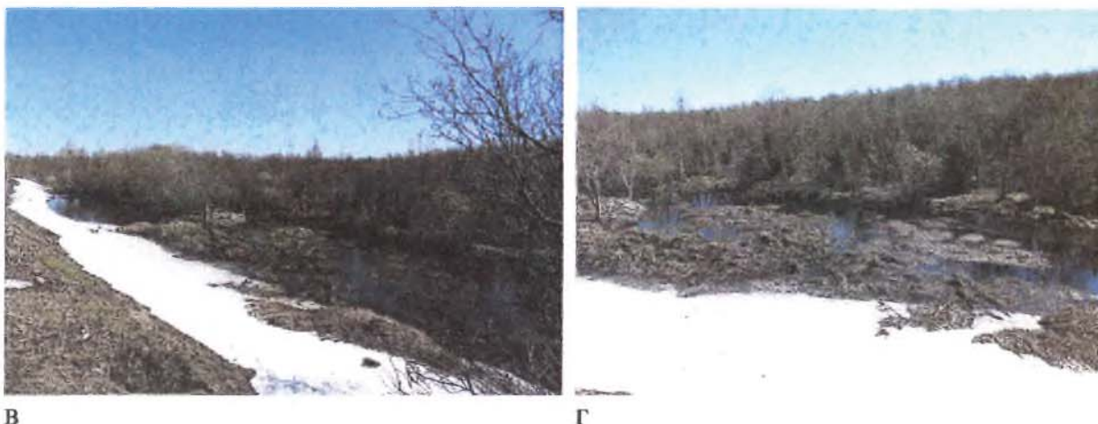
Рисунок 4 – ГТС-пометохранилище ОАО «Птицефабрика «Снежная» (июнь, 2017 г.): а – карты ГТС; б – переливная труба из карта в нагорную канаву; в, г – нагорная водоотводная канава вдоль ГТС.
