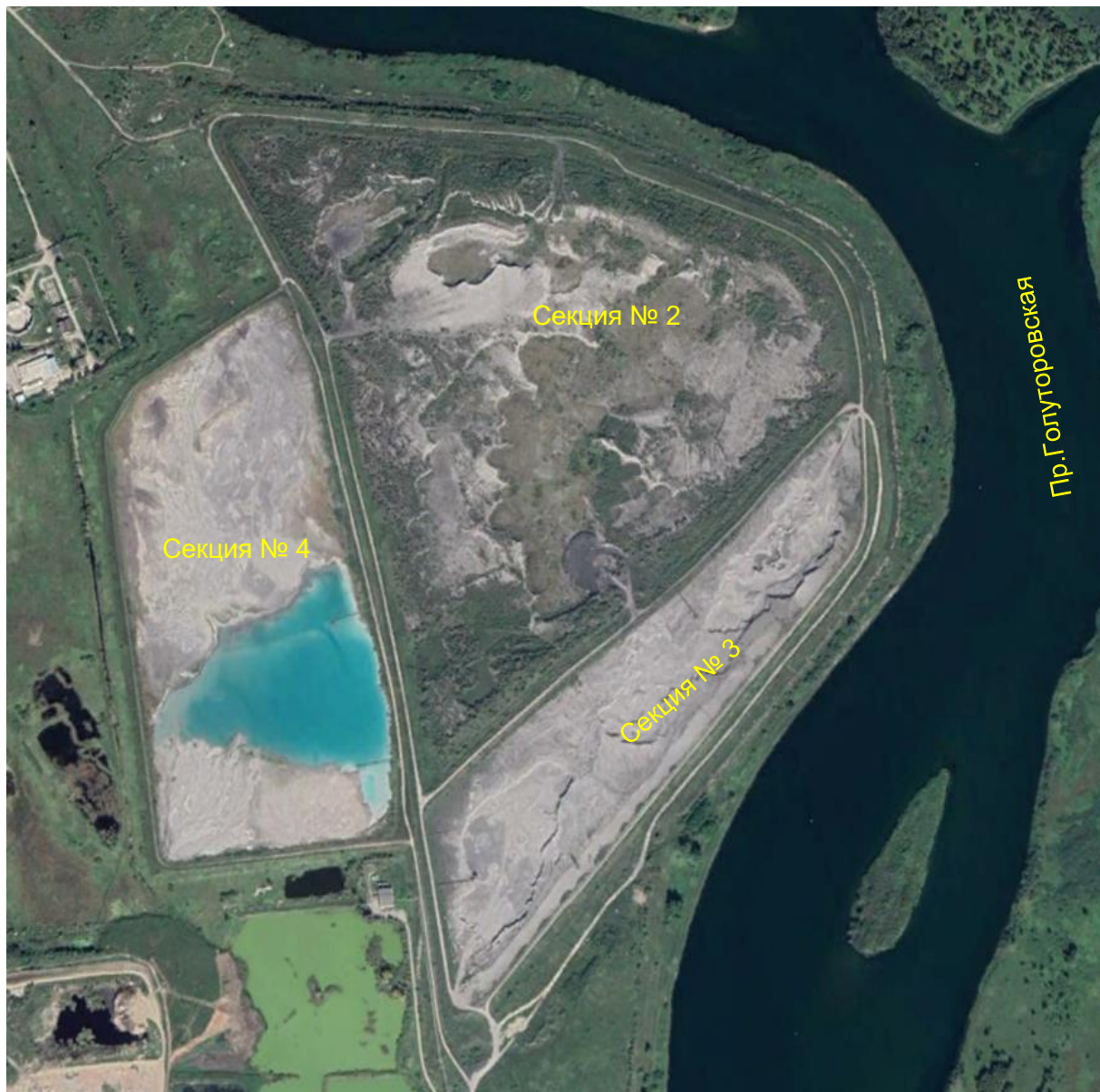
Рисунок 6.1 – Золошлакоотвал участка №1 Иркутской ТЭЦ-9
