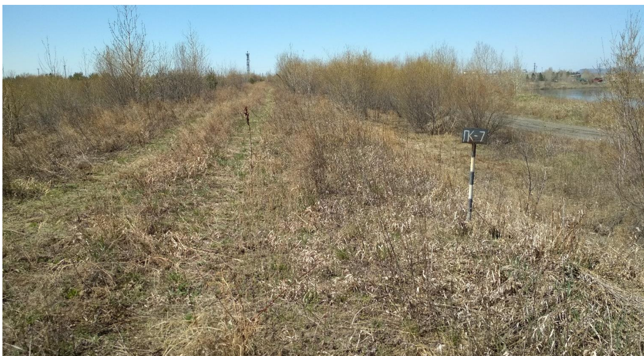
Рисунок 6.8 – Общий вид на северную часть ограждающей дамбы (район пьезометрического створа № 7).
