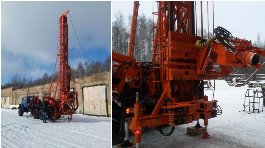
Рисунок 4.4-1. Буровая установка «УРБ-210»
