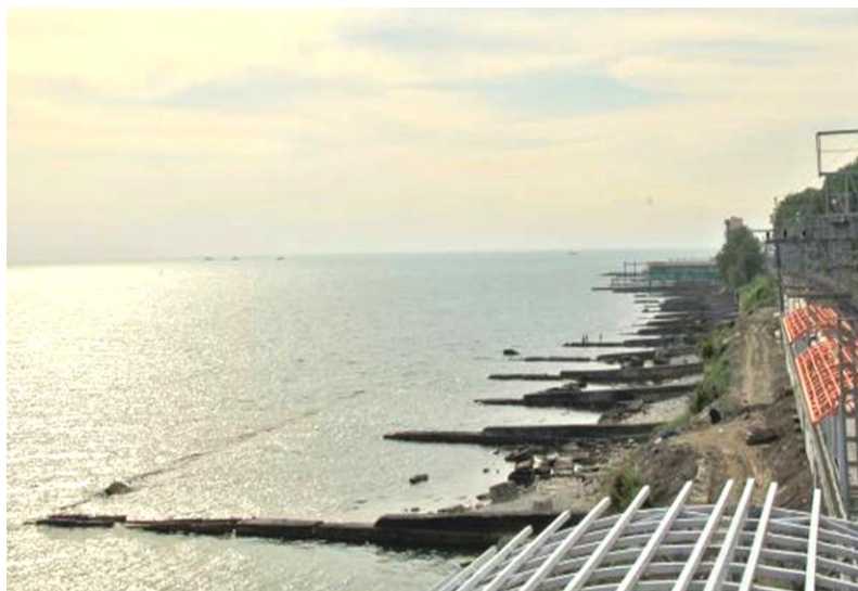
Рисунок 6.4. Берегозащитные сооружения на участке берега вблизи устья р. Мацеста
