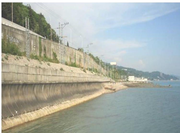
Рисунок 6.6. Волноотбойная стенка на участке берега в районе м. Видный
