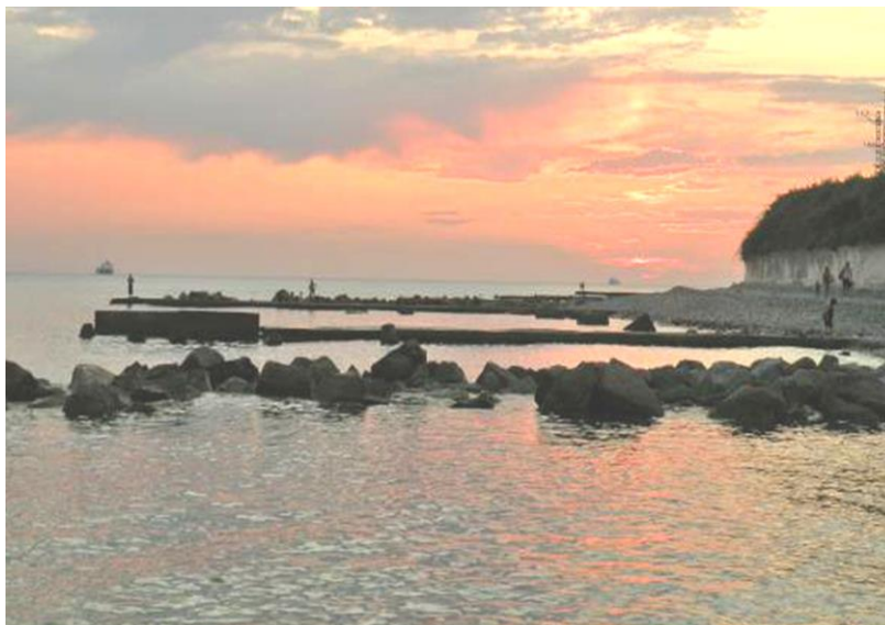
Рисунок 6.3. Берегозащитные сооружения на участке берега (пос. Магри)
