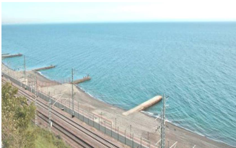
Рисунок 6.5. Пляжевые накопления материала в карманах бун (пос. Хоста)
