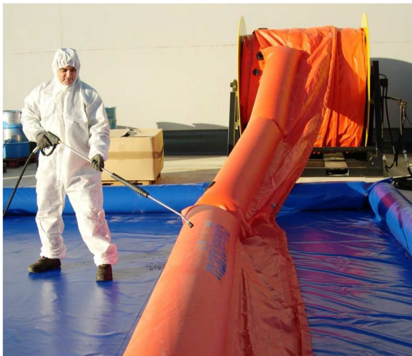
Обмыв бонов в надувной емкости при помощи моющего устройство высокого давления
