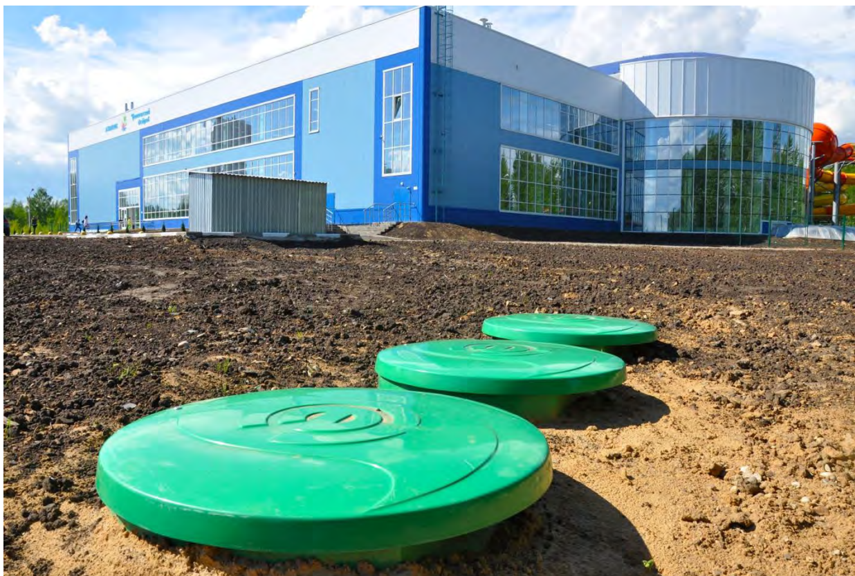
Установка Векса-М после монтажа (Аквапарк, г. Ярославль)
