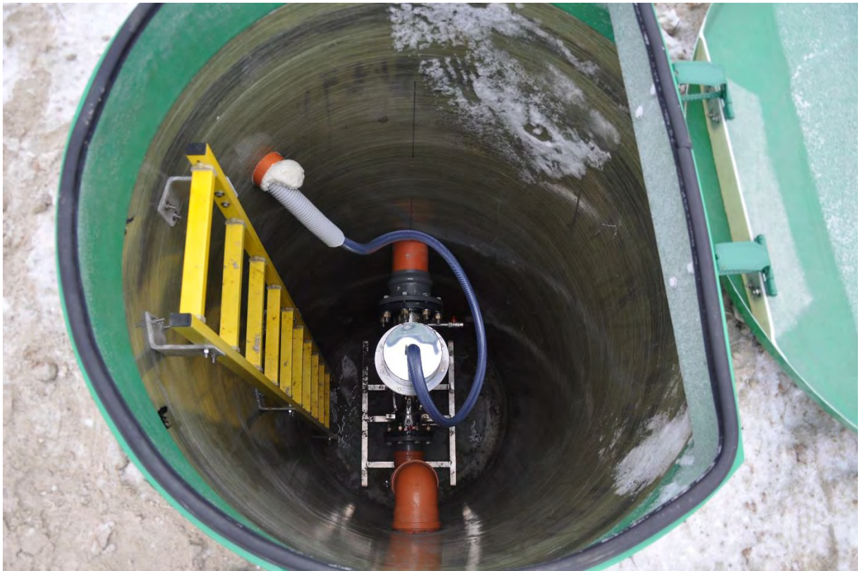
Монтаж станции СДВ (Завод Комацу, г. Ярославль)
