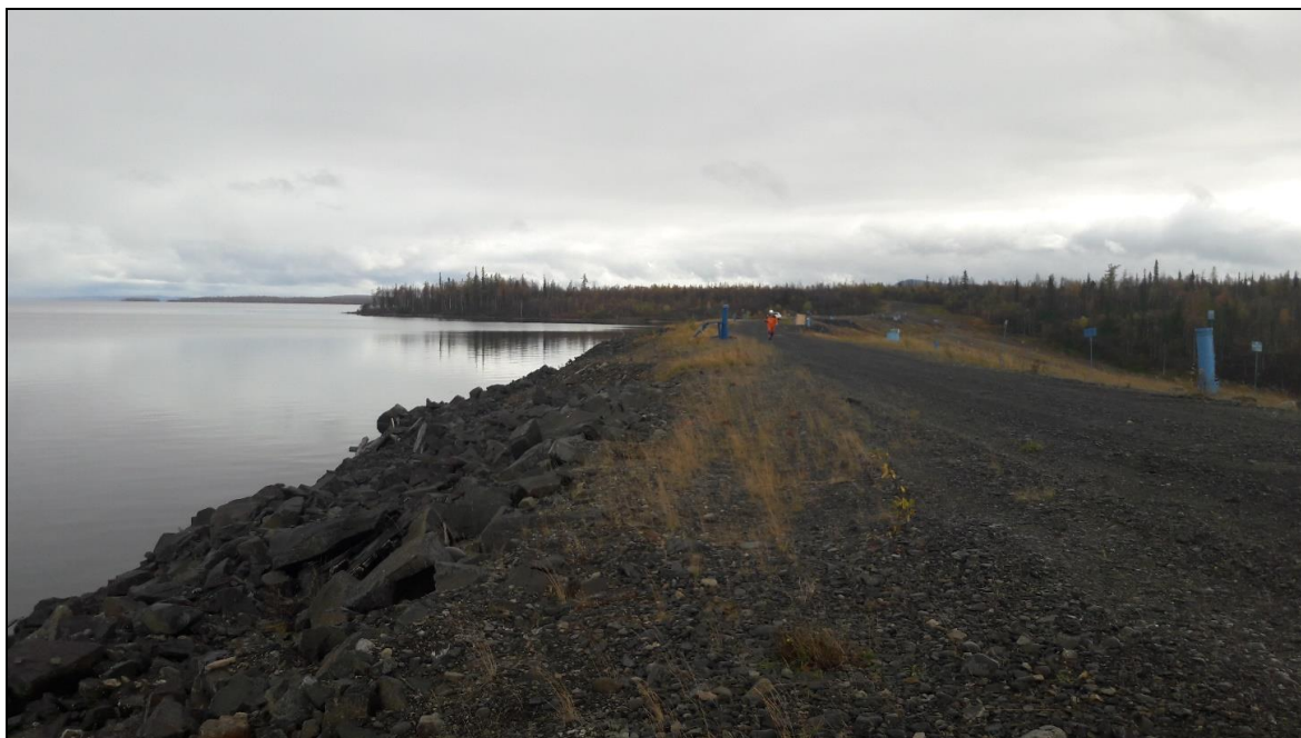
Правобережная плотина во II понижении
