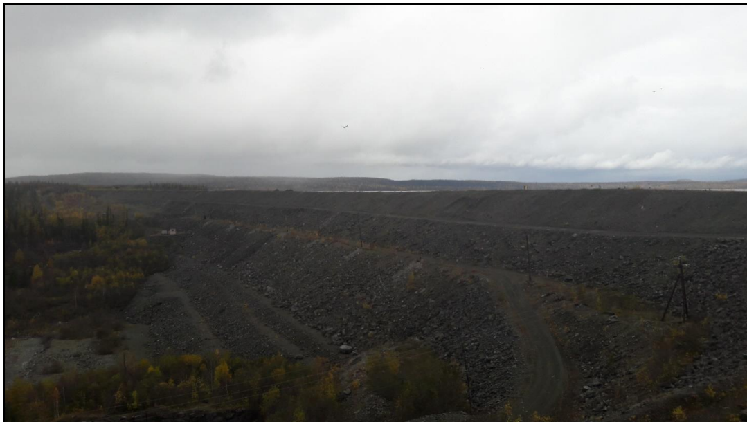
Внешний вид русловой плотины
