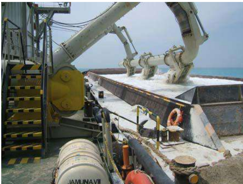
Рисунок Б.14 - Загрузка баржи при помощи распылительного трубопровода
