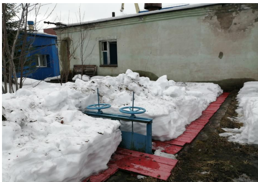
Рисунок 14 – Действующее здание насосной с песколовкой в северной части участка работ.
