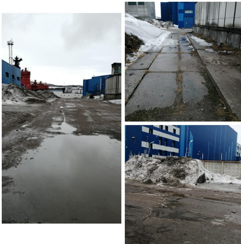
Рисунок 11 – Бетонное покрытие на участке работ.
