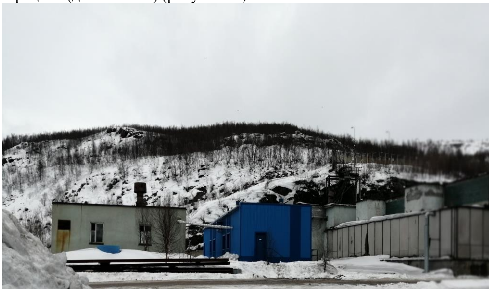
Рисунок 13 – Станция очистных сооружений
