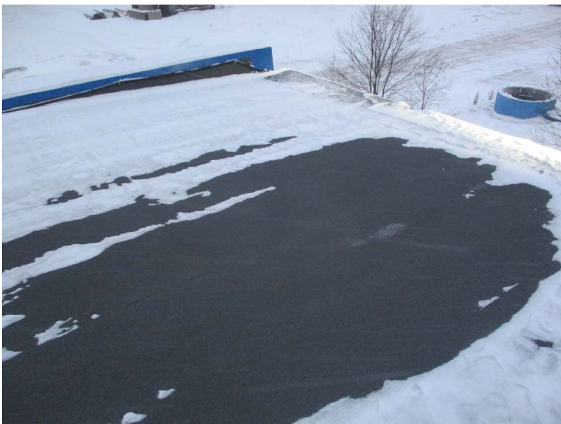
Фото 8. Вид кровли здания в осях 1-2.
