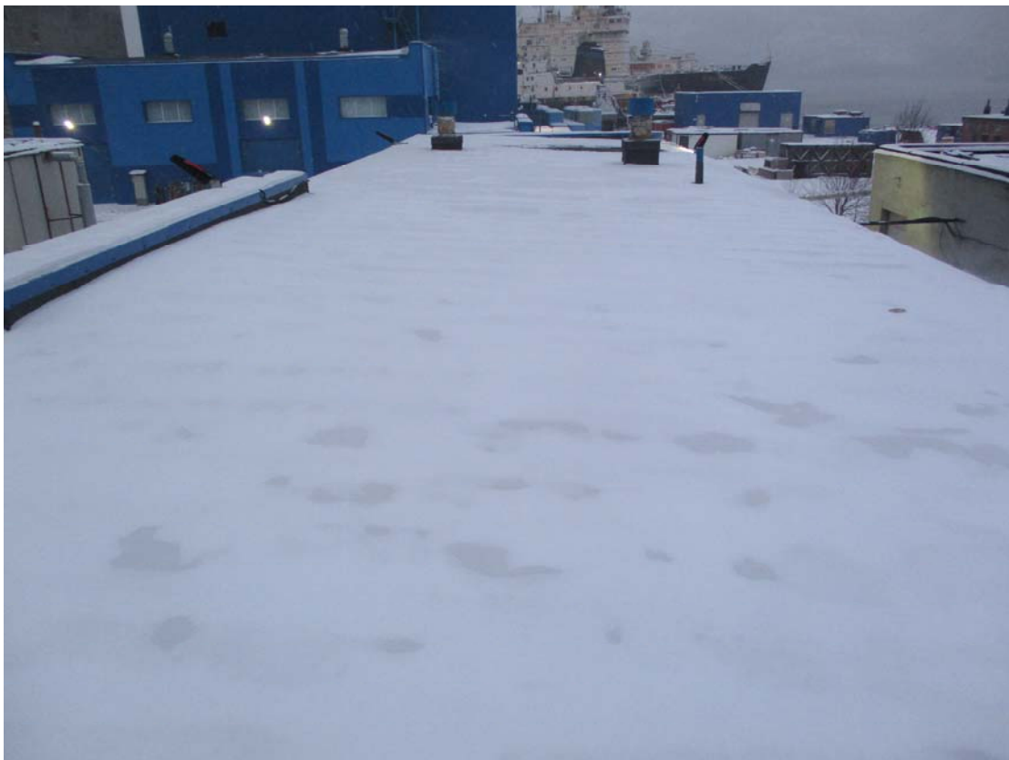
Фото 7. Общий вид кровли здания.
