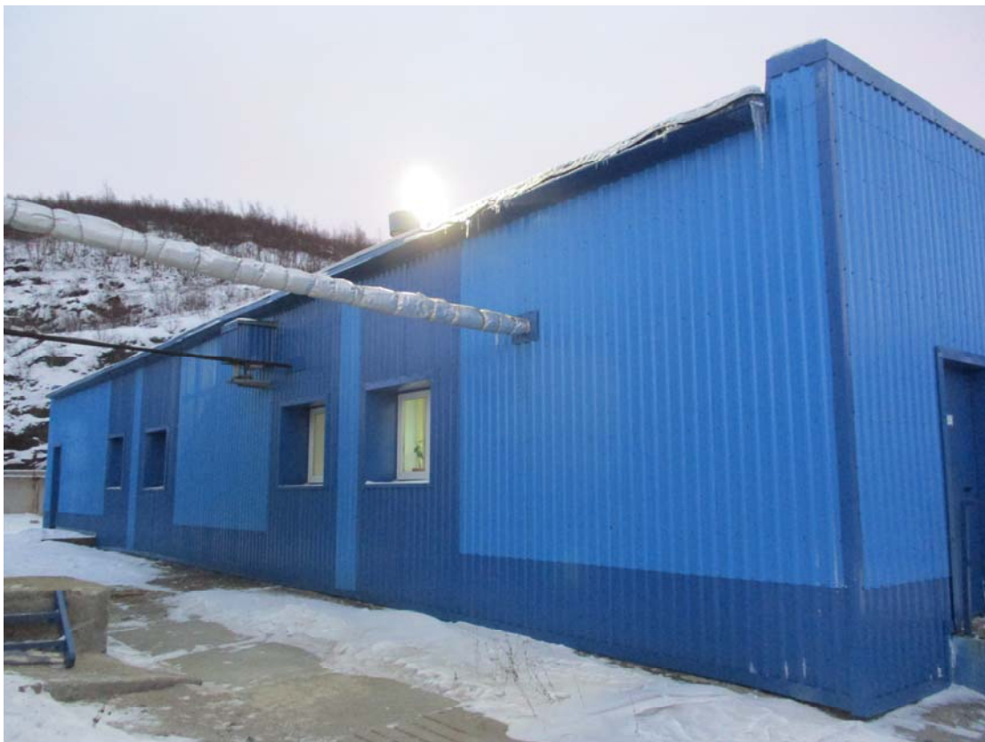
Фото 1. Общий вид здания.
