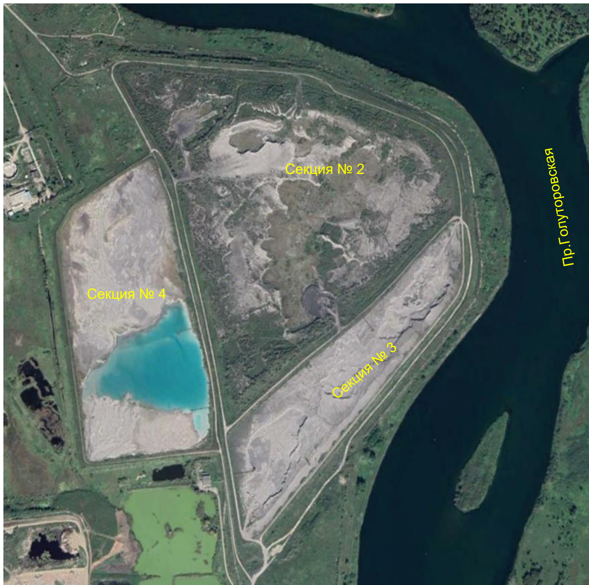
Рисунок 6.1 – Золошлакоотвал участка №1 Иркутской ТЭЦ-9
