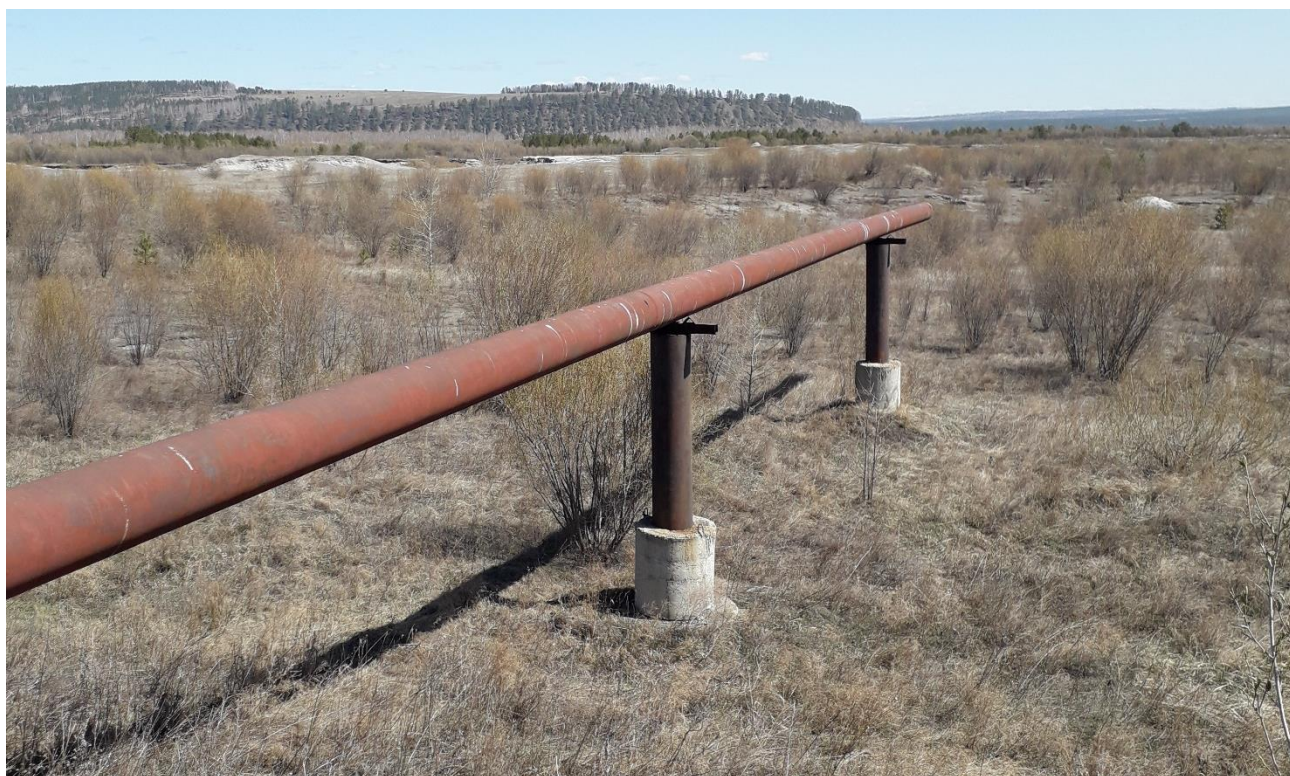
Рисунок 6.4 – Секция № 2. Общий вид на чашу секции № 2 с разделительной дамбы между секциями № 4 и № 2.
