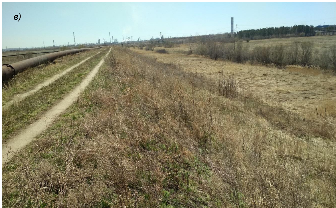
Рисунок 6.2 – Секция № 4. Общий вид: а – на чашу секции, б – на разделительную дамбу между секциями № 4 и № 2, в – на гребень и низовой откос западной ограждающей дамбы.
