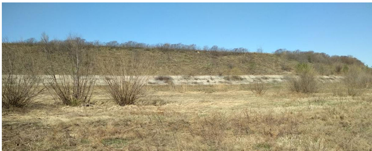
Рисунок 6.10 – Общий вид на низовой откос восточной части ограждающей дамбы.
