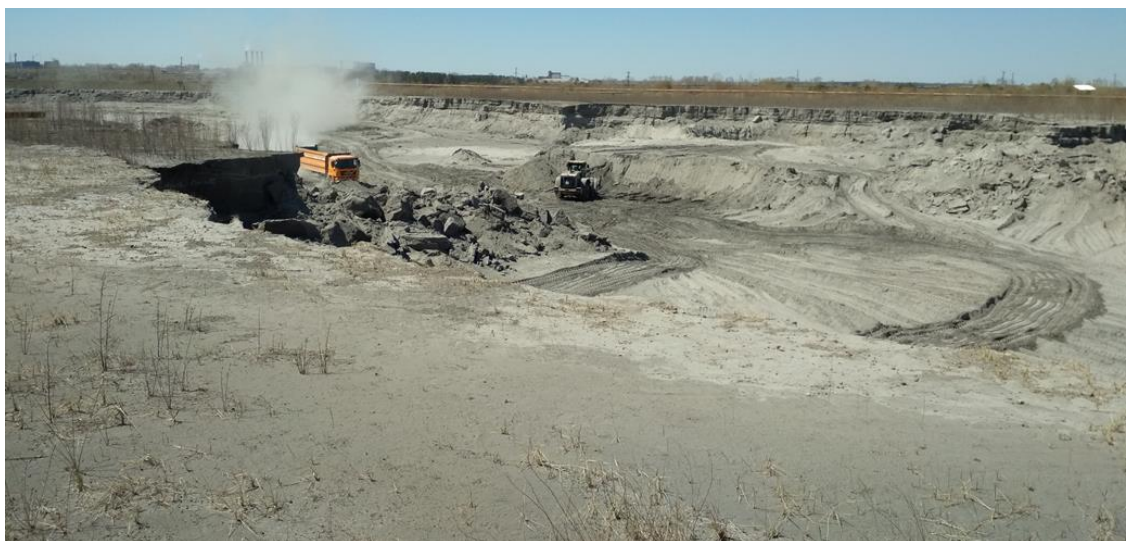
Рисунок 6.12 –Секция № 3. Общий вид на чашу секции с южной дамбы.
