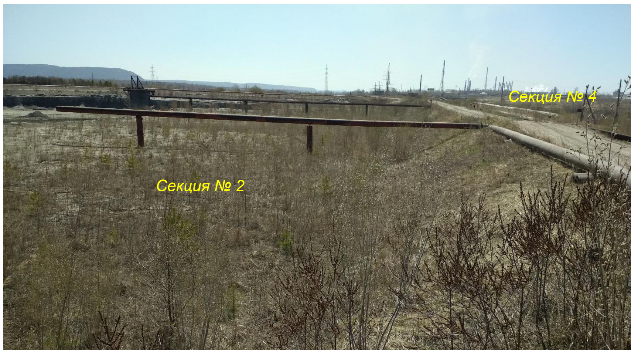
Рисунок 6.3 – Секция № 2. Общий вид – на верховой откос разделительной дамбы
