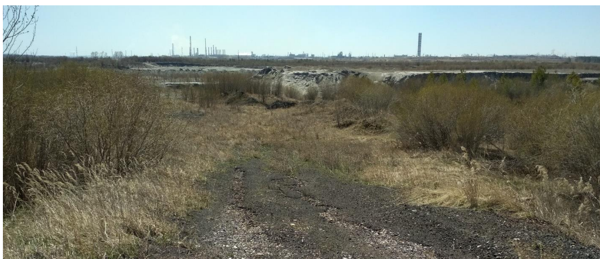
Рисунок 6.6 – Секция № 2. Общий вид на чашу секции № 2 со стороны северной ограждающей дамбы (съезд на точку скв. 21022).
