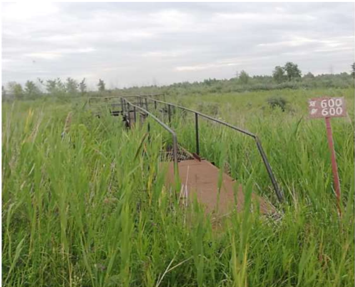
Рисунок 5 - Шандорный колодец секции №2 со служебным мостиком
