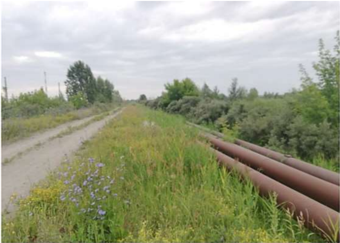
Рисунок 4 - Дорога на гребне ограждающей дамбы
