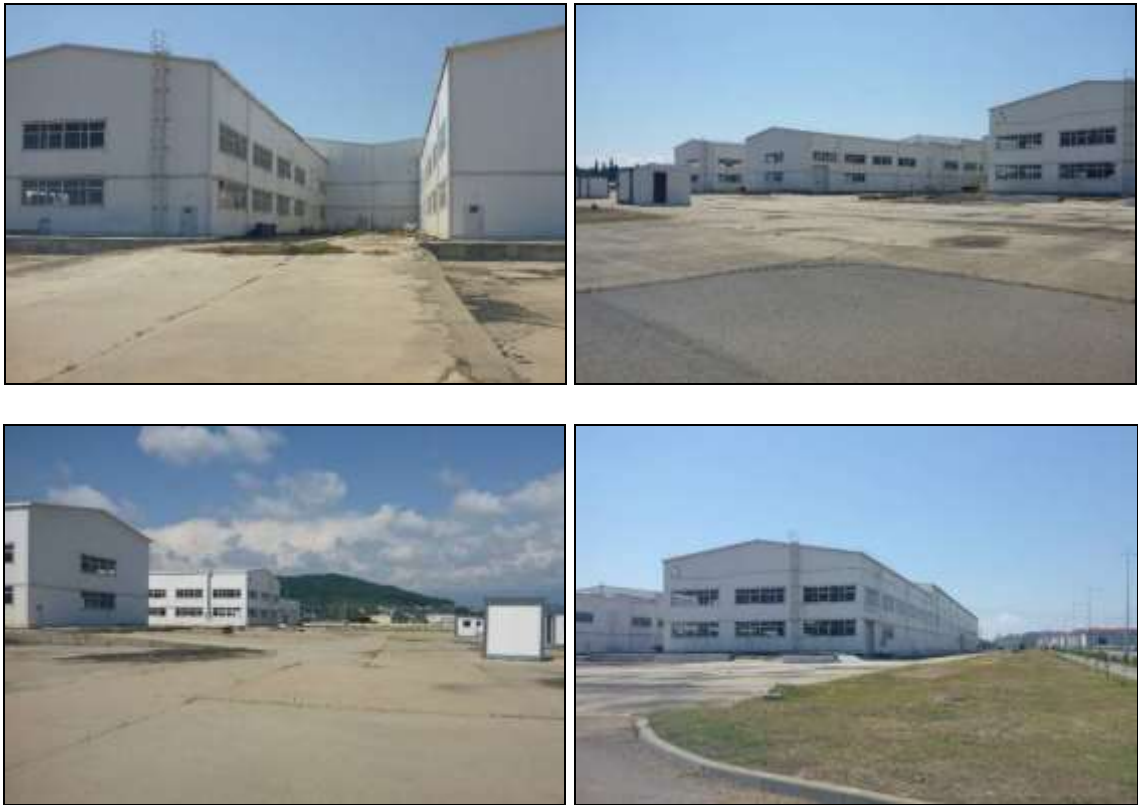
Рисунок 5.10 – Главный распределительный центр ОАО «РЖД» на территории кластера № 6
