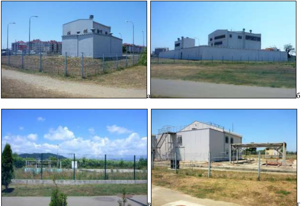
Рисунок 5.20 – Насосные станции и очистные сооружения на территории кластеров: а-б) № 6; в) № 7; г) № 9
