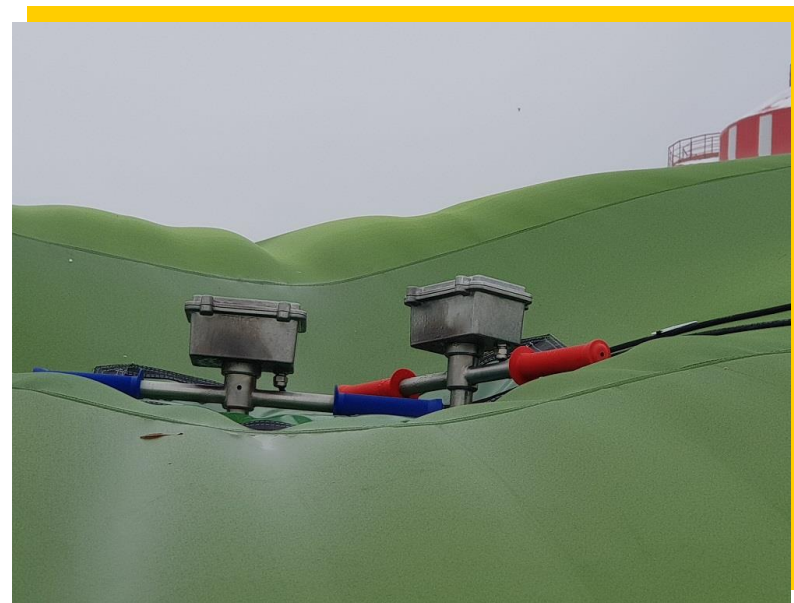
Щупы измерения кислорода и температуры
