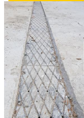
Каналы принудительной аэрации
