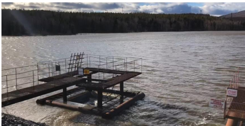
Рис. 2.1.2 -. Общий вид на ШК №№ 1,2 с гребня ограждающей дамбы
