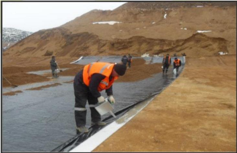
Рис. 4. Просыпка зоны нахлеста бентонитовыми гранулами
