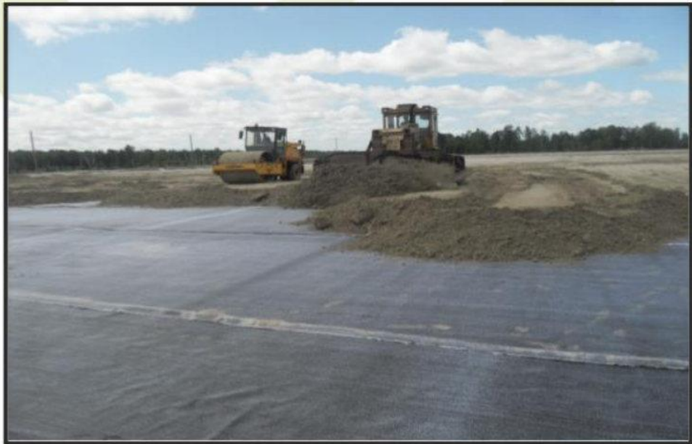
Рис. 6 Устройство обратной засыпки
