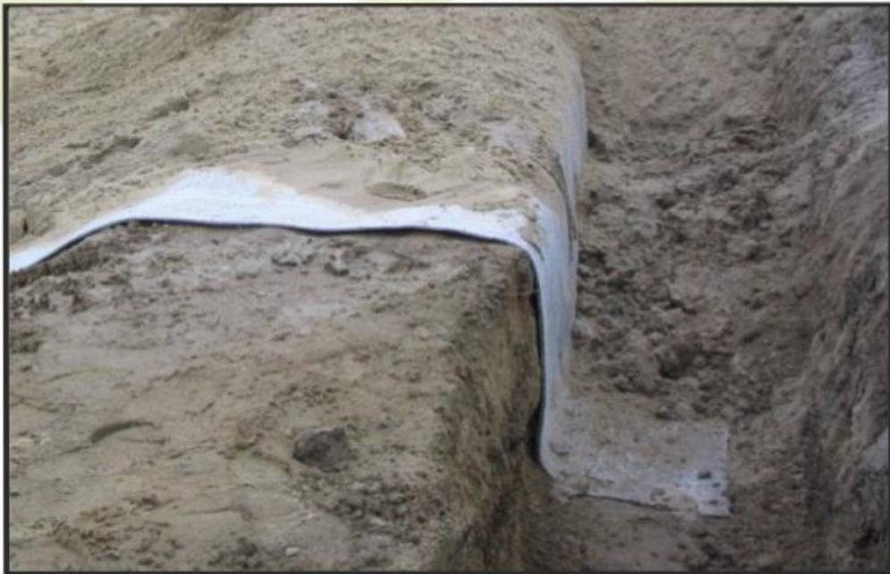
Рис. 2 Устройство анкерного замка
