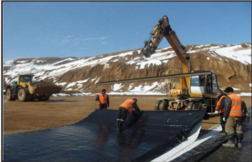
Рис. 3 Укладка бентонитового мата
