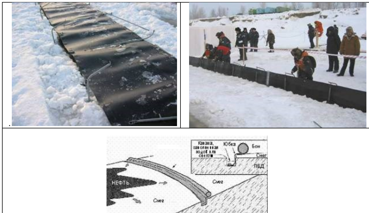
Рисунок 34 – Способы постановки заграждений в зимний период
