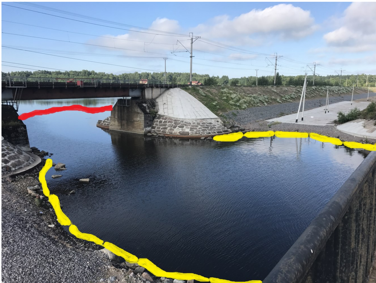
Рисунок 30 – Рубежи постановки боновых заграждений на проливе Ниемельский
