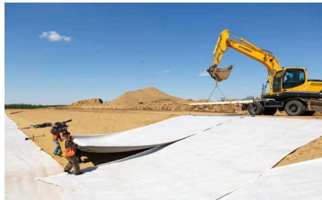
Рис. 5 – Укладка бентонитового мата
