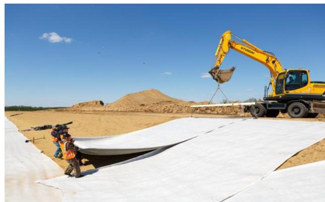
Рис. 5 – Укладка бентонитового мата
