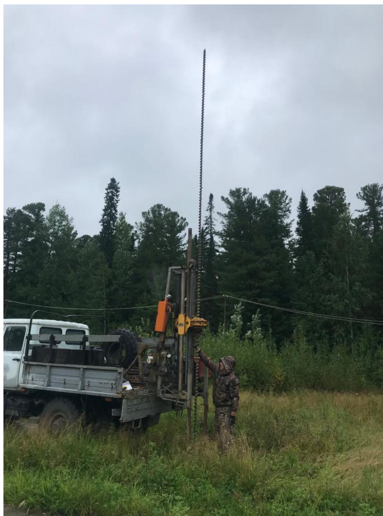
Фото 4.1 – Процесс бурения инженерно-геологических скважин (СКВ/23(1)1)
