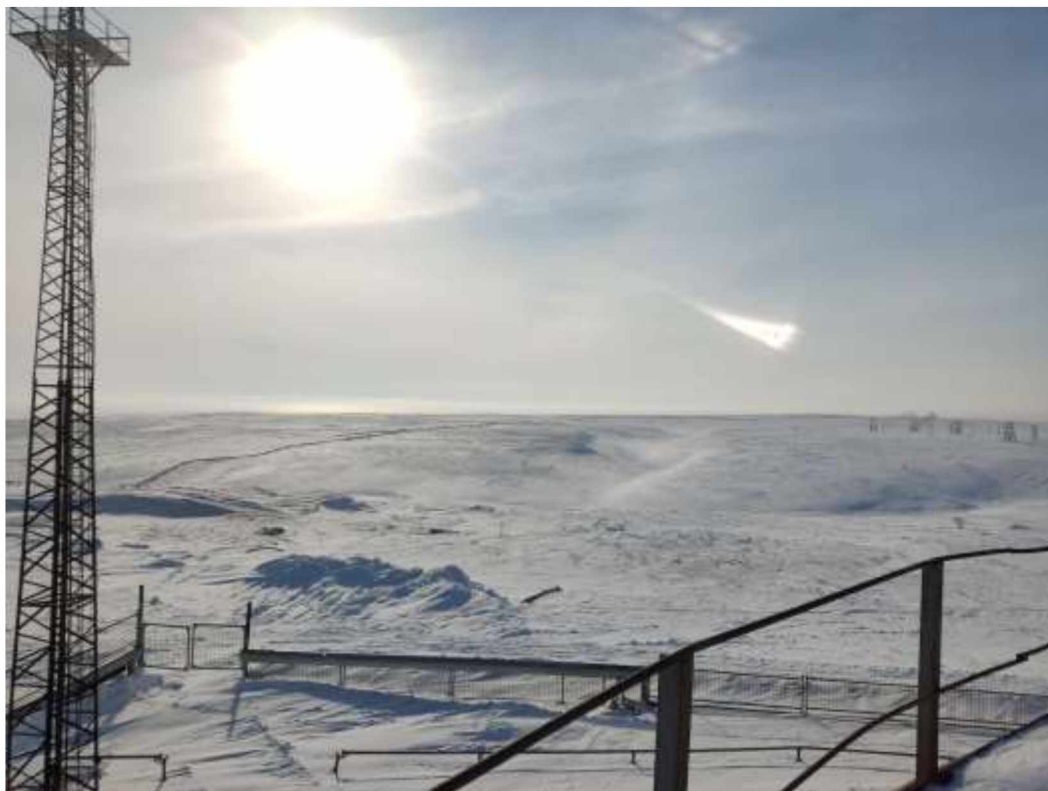
Рисунок 5.2.2 – Территория строительства (ниже участка строительства, вид на ручей без названия №1)
