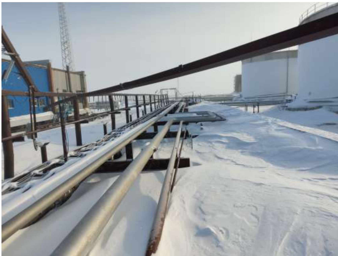
Рисунок 5.2.4 – Территория строительства (южная часть)
