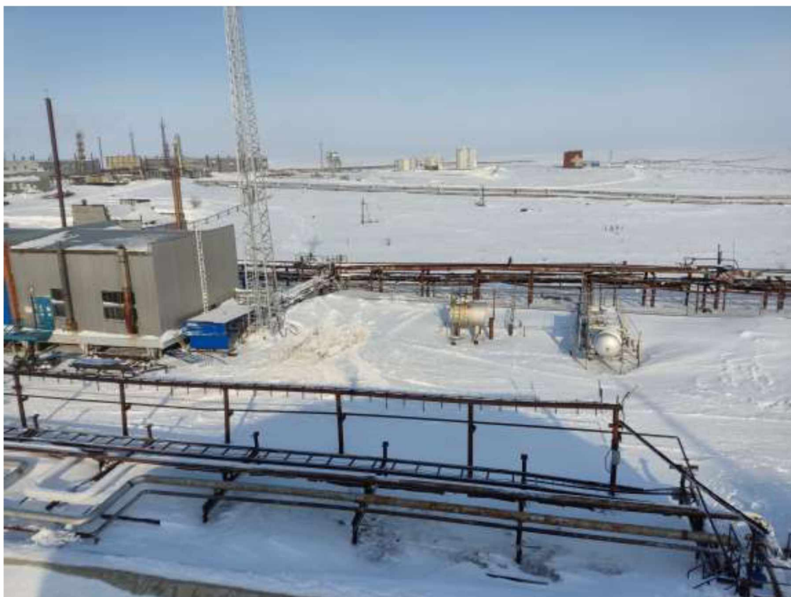
Рисунок 5.2.5 – Территория строительства (центральная и северная часть)
