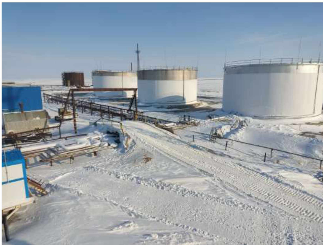
Рисунок 5.2.3 – Территория строительства (южная часть)
