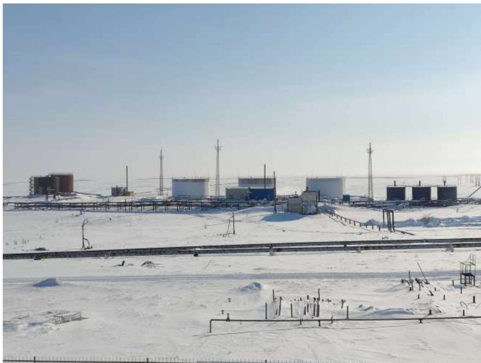
Рисунок 5.2.6 – Территория строительства (центральная часть)
