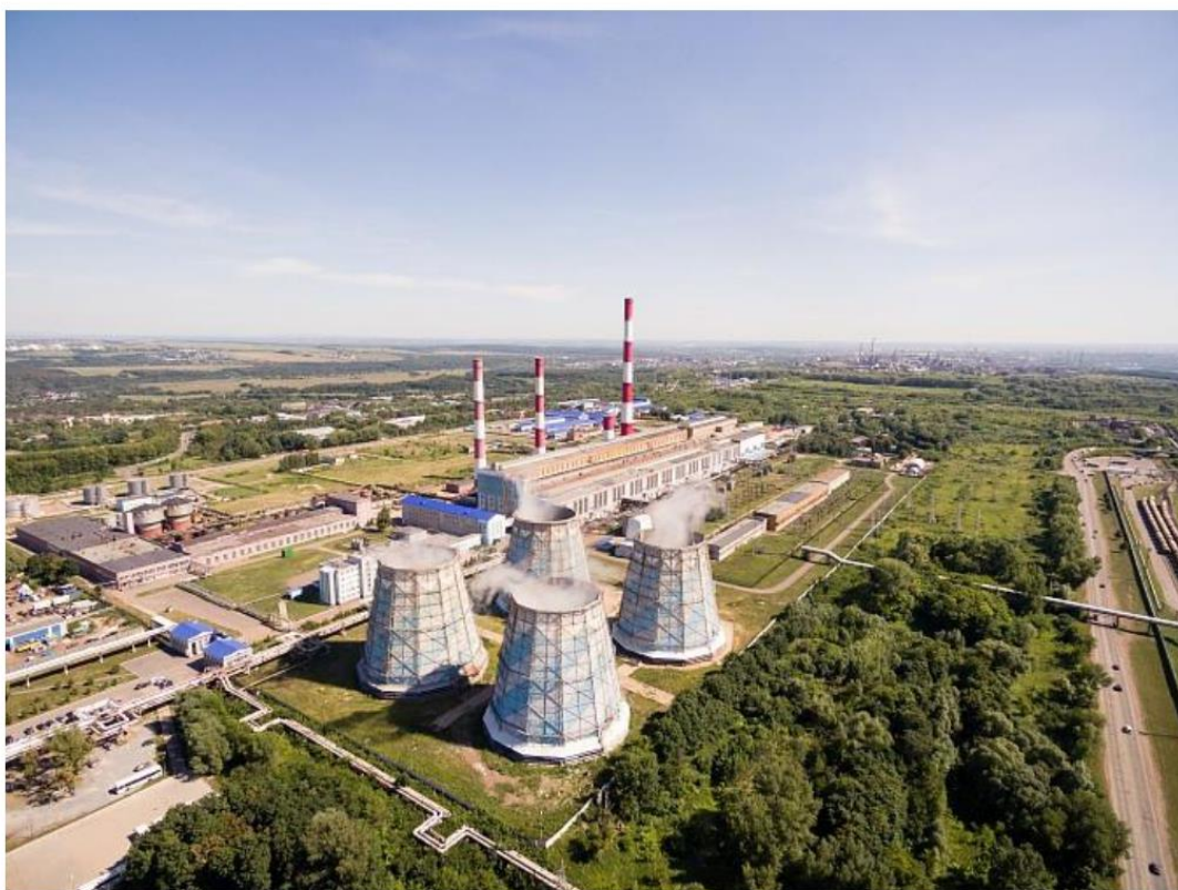
Рис. 1 Обзорный вид сверху на ТЭЦ-4 ТЭЦ-4 располагается на северной окраине г. Уфы.
