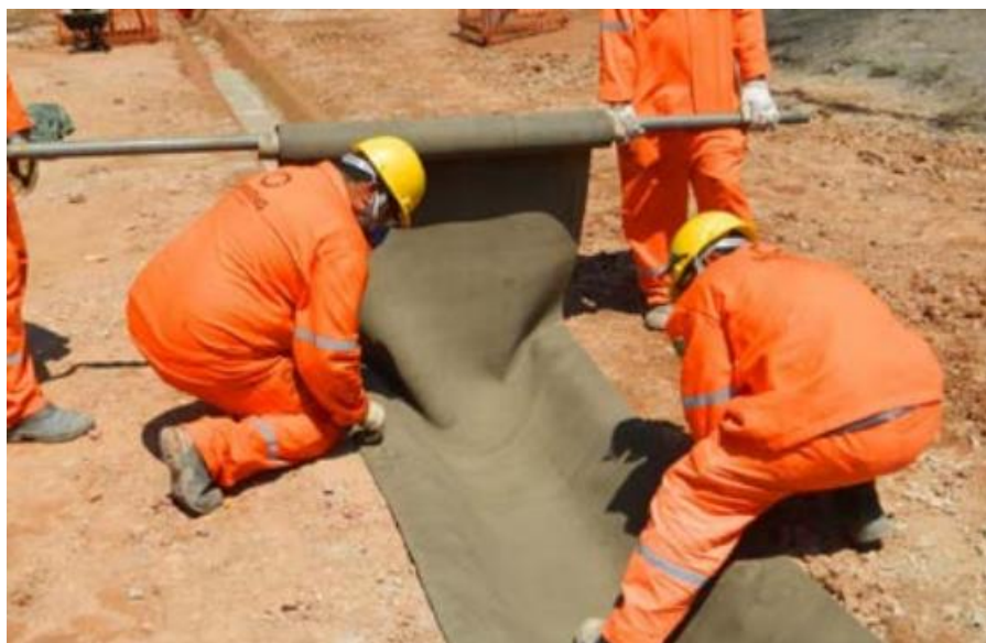
Рисунок 2– Крепление бетонного полотна
