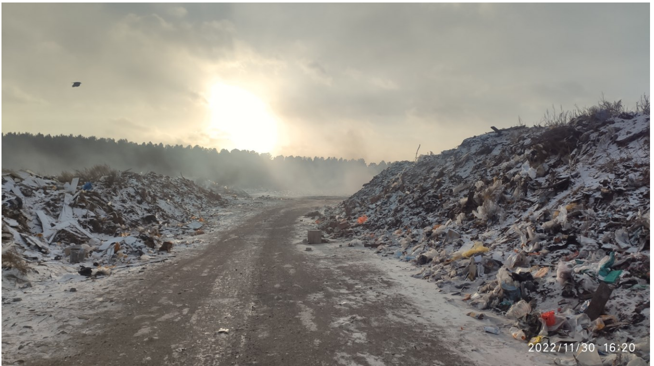
Рис. 10. Вид на свалку
