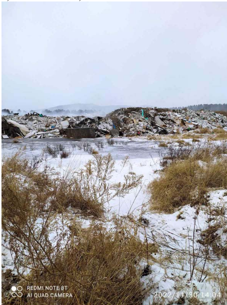
Фото №2. Вид с Т.Н. 2 на свалку ТБО и обводненный участок местности.
