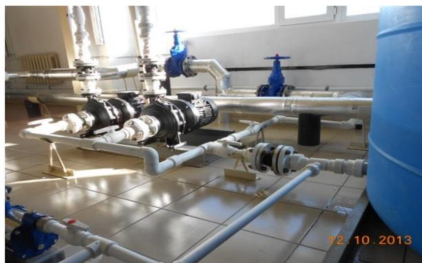
трубопроводы ила предусматривается насосами-дозаторами.
