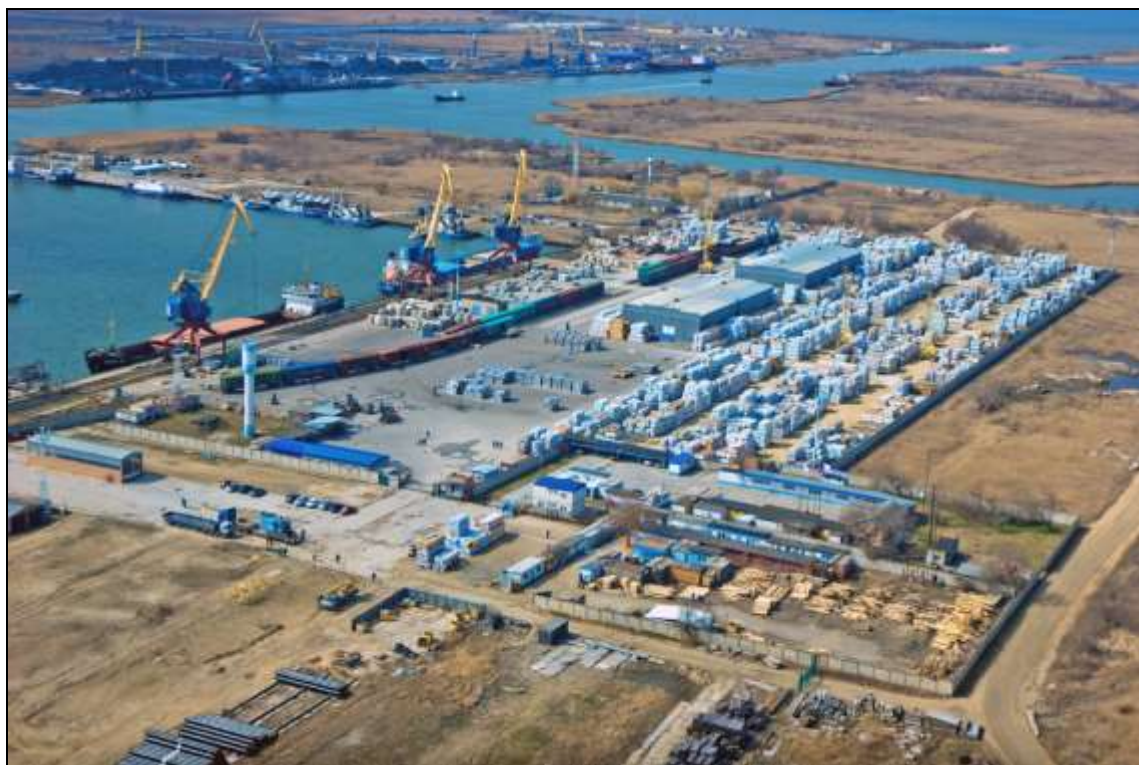
Рисунок 1 – Общий вид на промплощадку ООО «Газпром транссервис»
