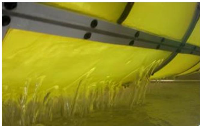
Обратная промывка осуществляется очищенной водой промывными насосами, интегрированным в установки микрофильтрации. Осадок (промывные воды) по самотечной системе отводится в одну из секций аэробного резервуара-накопителя-уплотнителя осадка.
