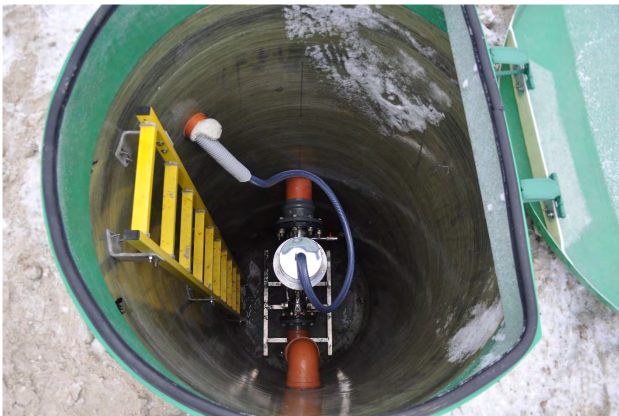
Монтаж станции СДВ (Завод Комацу, г. Ярославль)
