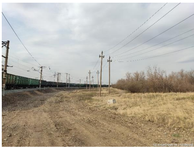
Рисунок 3.6.6 – Участок железнодорожной линии вблизи участка изысканий, южная часть СЗЗ
