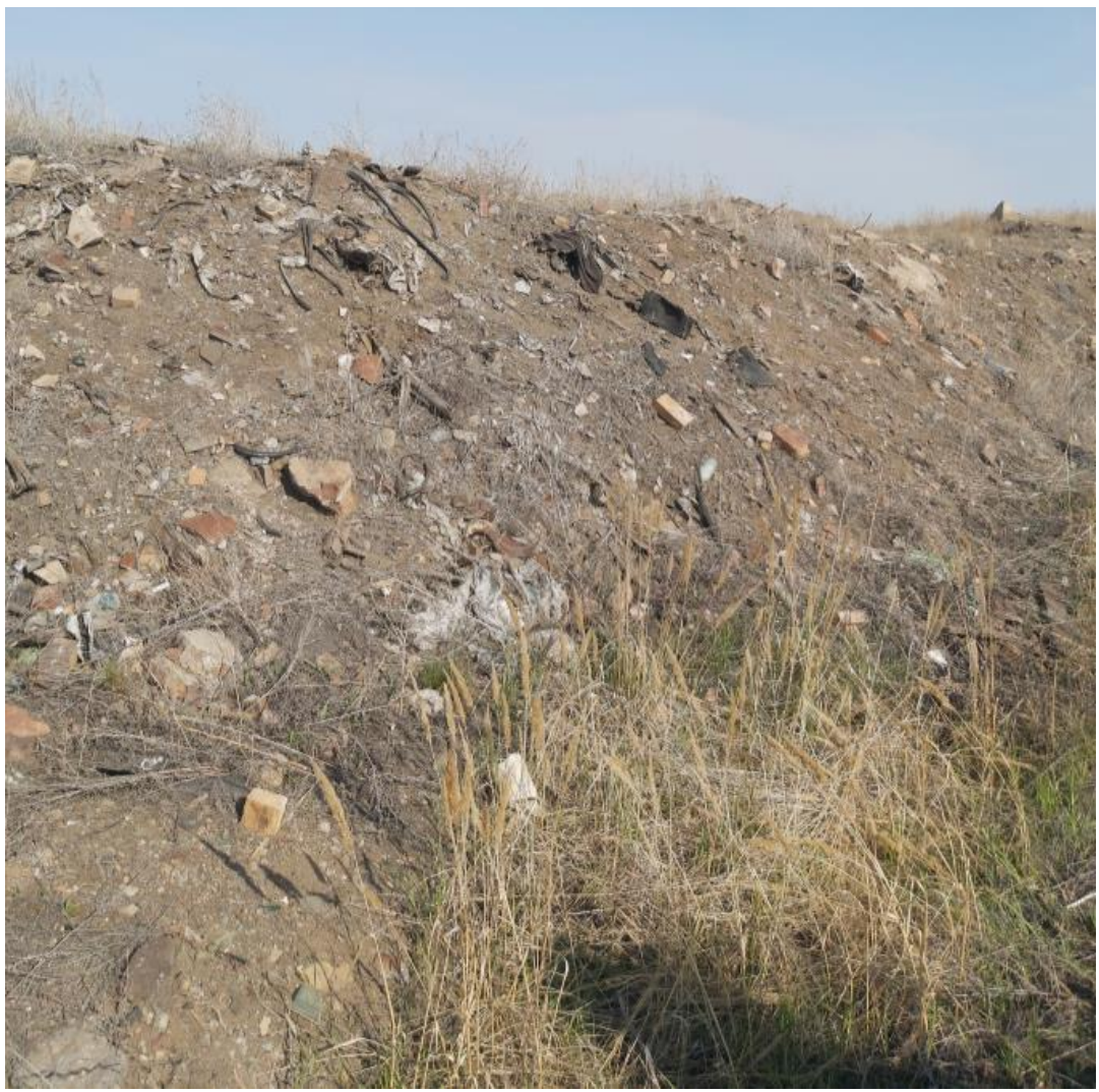
Рисунок 3.3.5 – Техногенные грунты ТГ-3 в юго-восточной части участка работ
