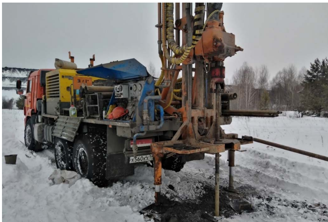
Рисунок 3.2 – Бурение скважины С-9 буровой установкой УРБ-2ДЗ
