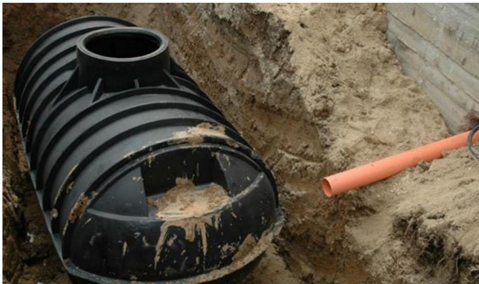
Рисунок 5.1 – Емкость канализационная
