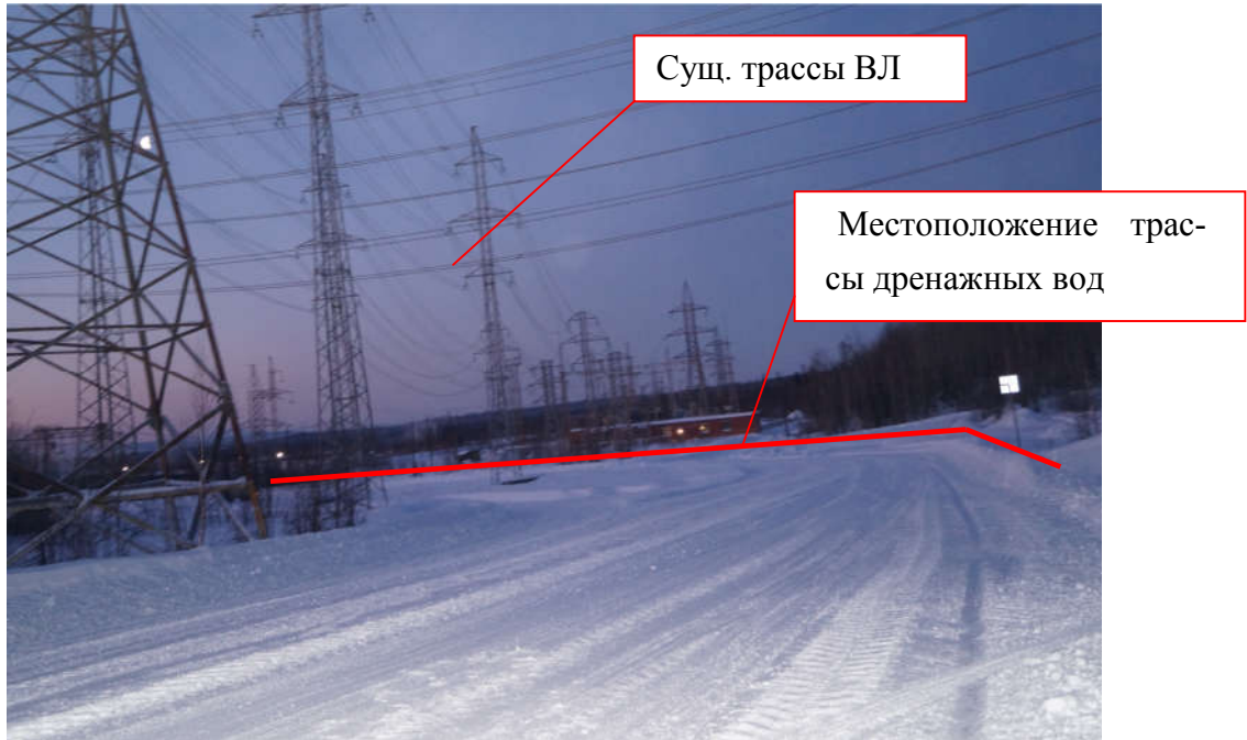
Рисунок 15 – Трасса при переходе под дорогой и существующими ВЛ
